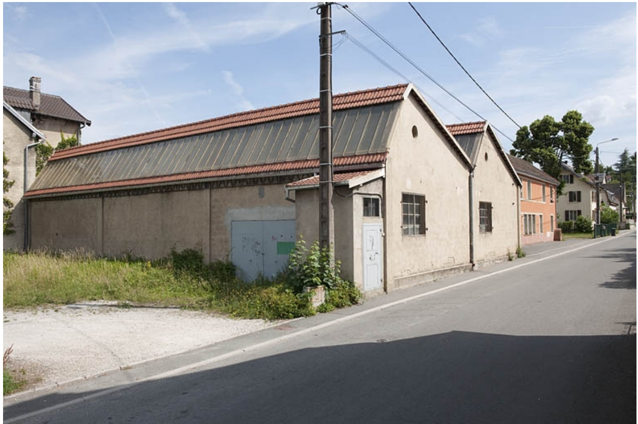
Atelier de fabrication. Extension occidentale.
