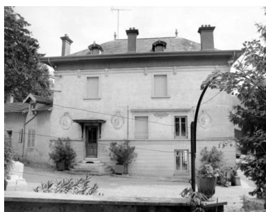
Façade latérale gauche du bureau. Phot. Yves Sancey IVR43_19933900187X
