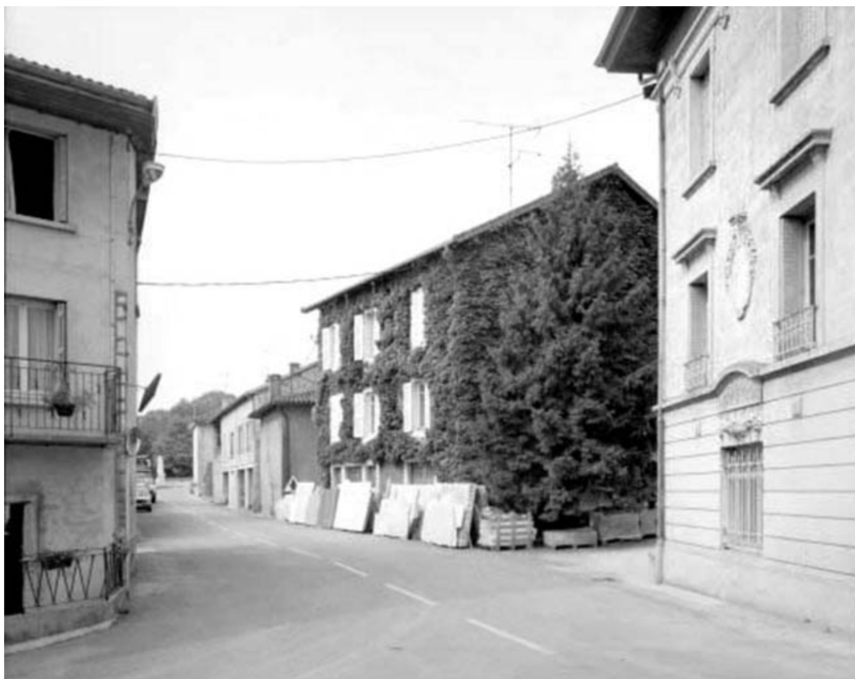
Logement patronal et logement d'ouvriers.
