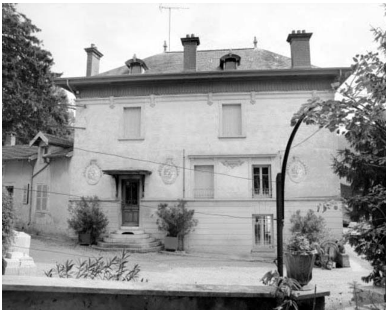
Façade latérale gauche du bureau.
