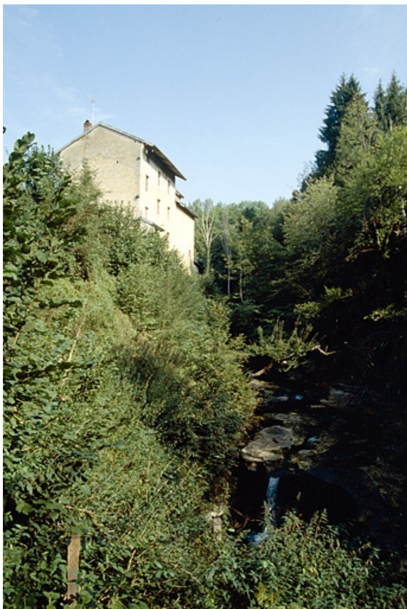
Façade postérieure du logement patronal.
