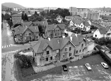
Vue d'ensemble de la cité ouvrière : sud-ouest. Phot. Yves Sancey IVR43_19932500089X
