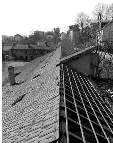
Toiture de la menuiserie. Phot. Yves Sancey IVR43_19932500047X
