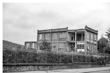
Destruction de l'usine, 22 août 1993 : atelier (2a) vu depuis le nord. Phot. Laurent Poupard IVR43_19932500175Z
