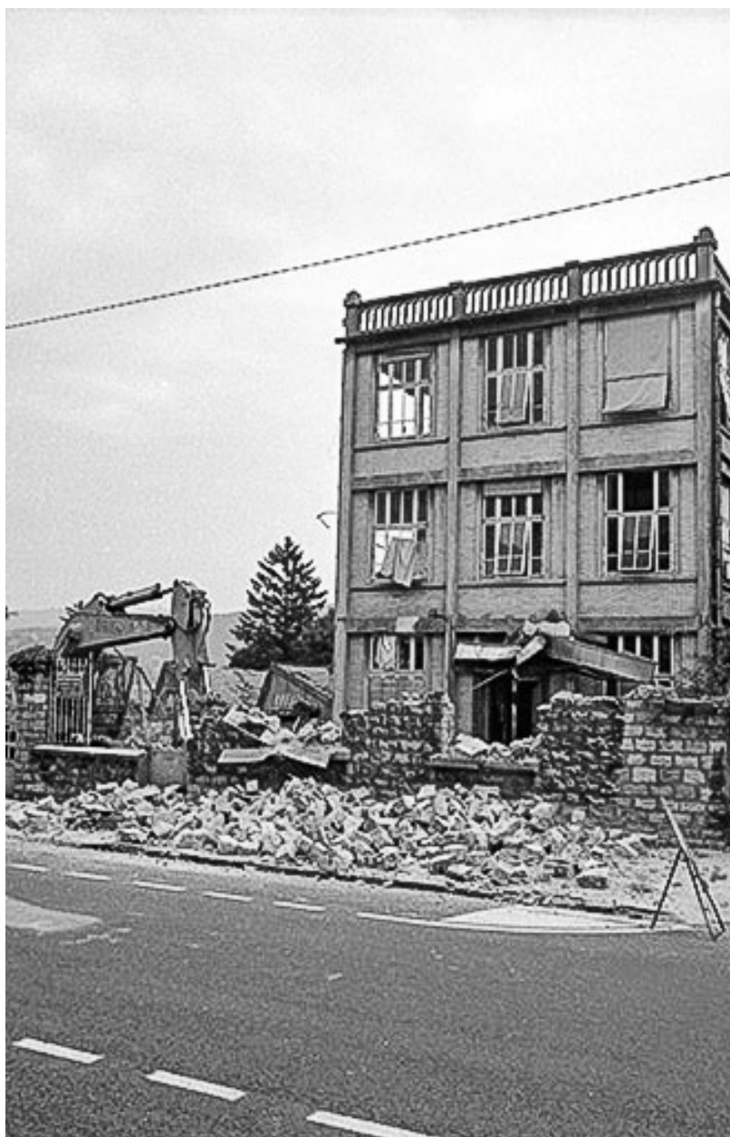
Destruction de l'usine, 23 août 1993 : pelle mécanique et atelier (2a) depuis l'ouest.
