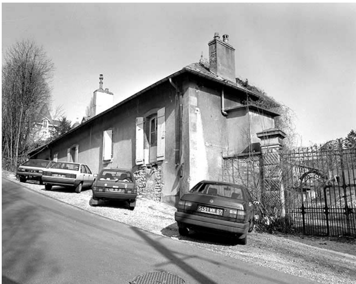
Logement d'ouvriers (21), depuis la rue Roy.
