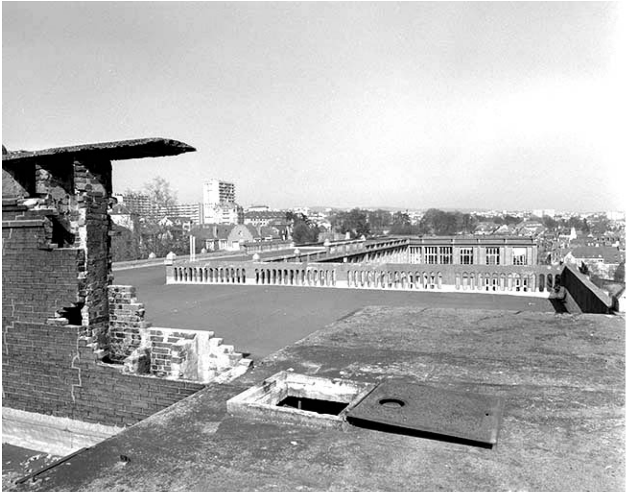
Toit terrasse des bâtiments (6, 8, 9).
