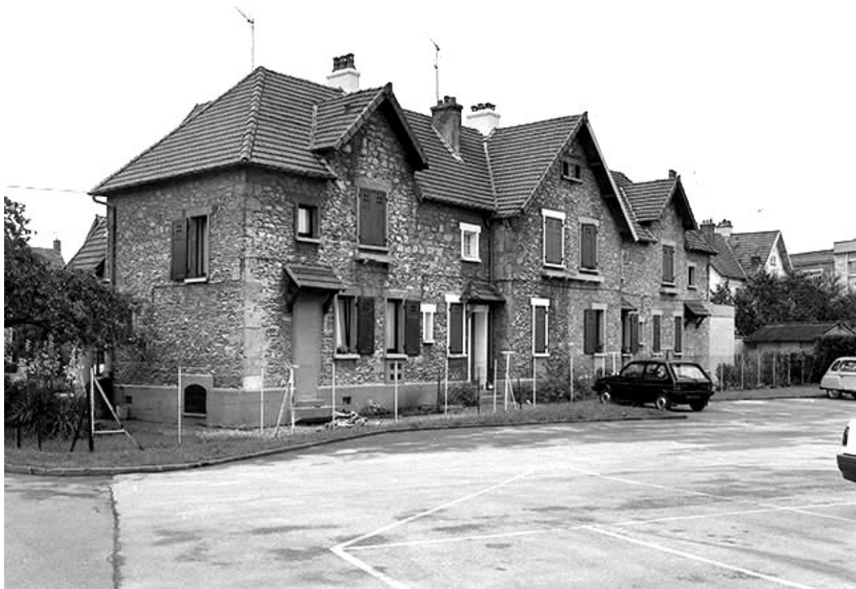
Façade postérieure de l'immeuble de type 1, 10, 12, 14, 16 rue du Bougney.
