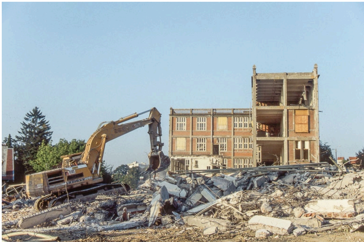
Destruction de l'usine, 20 août 1993 au matin : pelle mécanique et ateliers depuis le nord-est.
