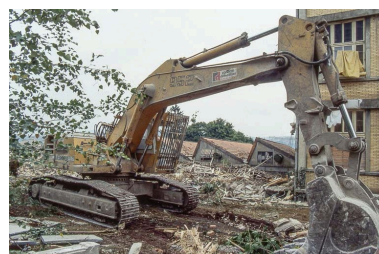
Destruction de l'usine, 23 août 1993 : pelle mécanique. Phot. Laurent Poupard IVR43_19932500180ZA
