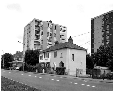
Maison de type 2, rue Xavier Marmier. Phot. Yves Sancey IVR43_19932500092X
