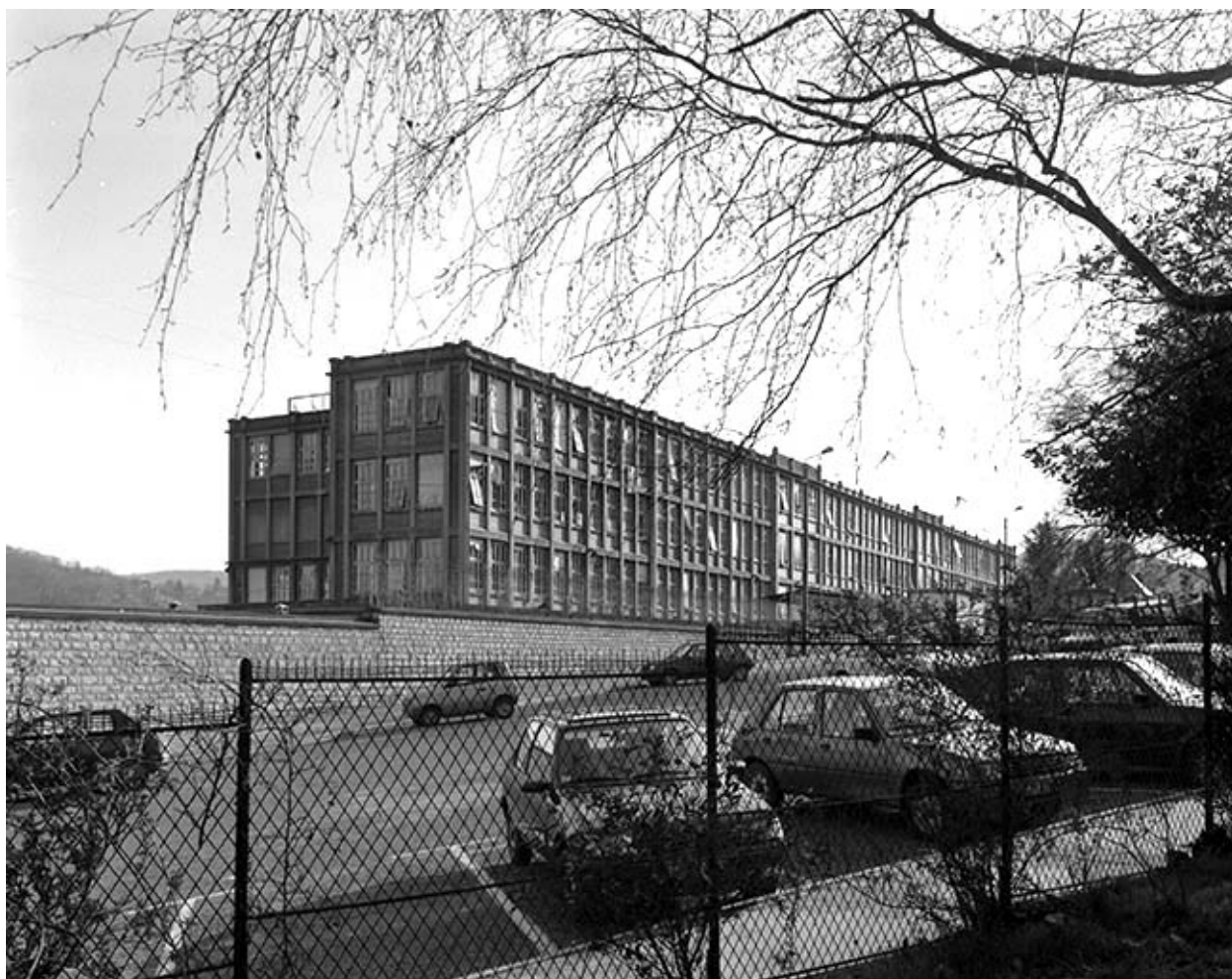
Façade antérieure et façade latérale gauche.
