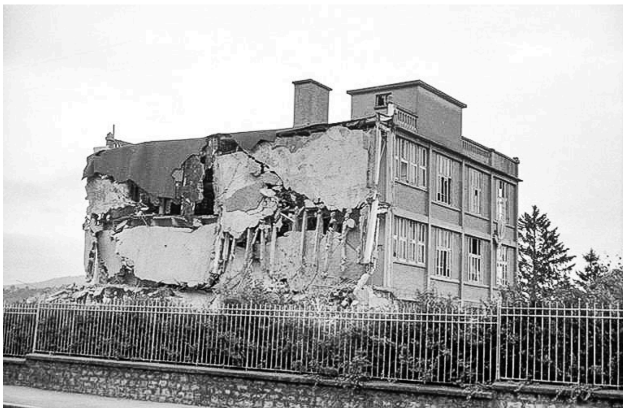
Destruction de l'usine, 22 août 1993 : ateliers (6a, 2a) vus depuis l'ouest.
