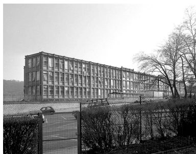
Façade antérieure vue de trois quarts gauche. Phot. Yves Sancey IVR43_19932500014X
