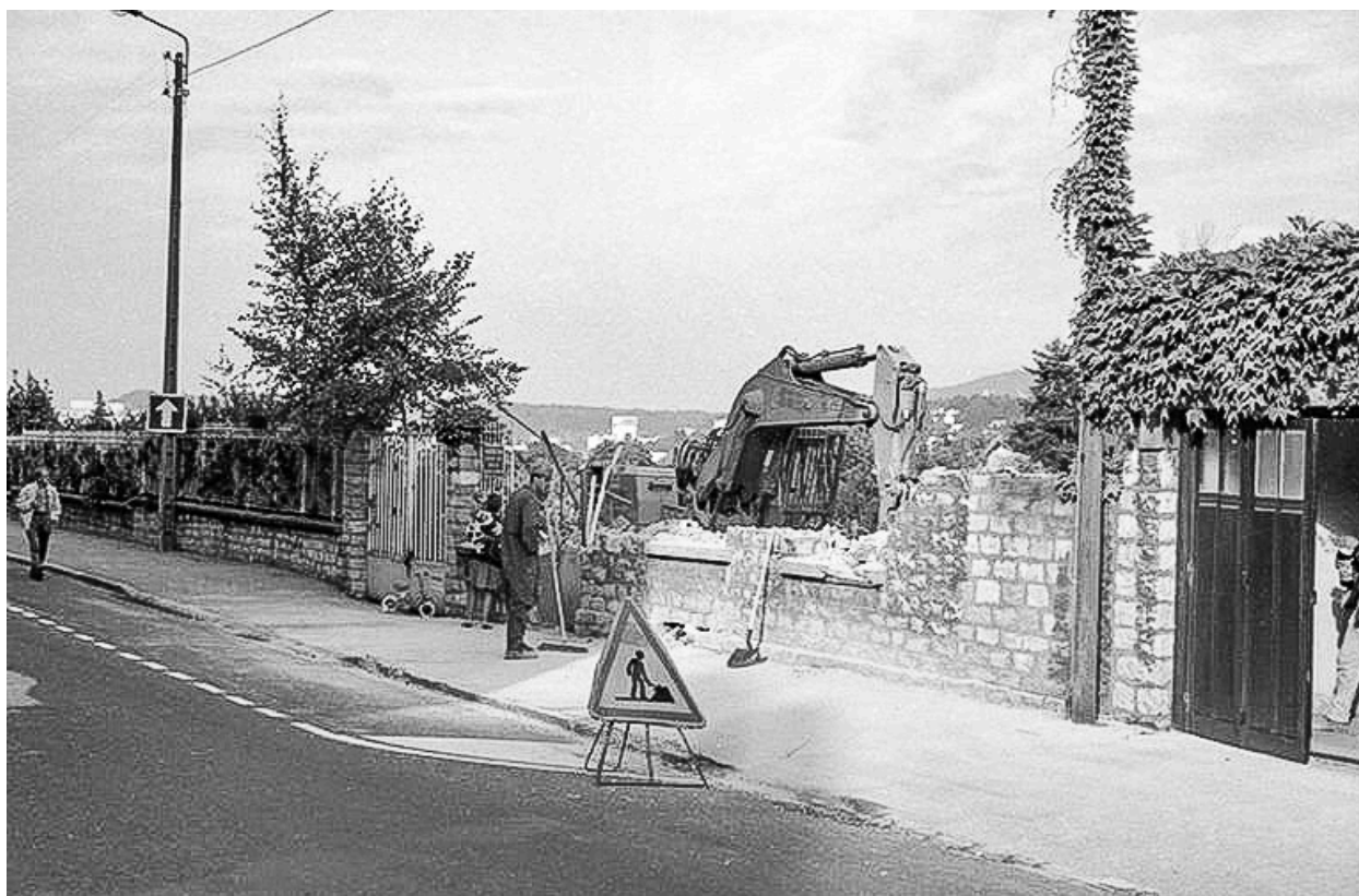
Destruction de l'usine, 24 août 1993 au soir : pelle mécanique et ouvrier.
