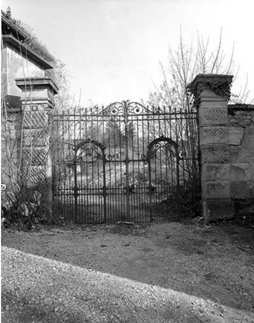
Grille d'entrée du site ancien.
