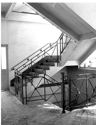
Escalier. Phot. Yves Sancey IVR43_19932500033X
