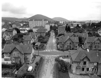
Vue d'ensemble de la cité ouvrière : sud. Phot. Yves Sancey IVR43_19932500088X
