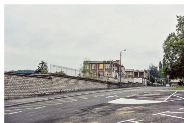
Destruction de l'usine, 22 août 1993 : façade sur l'avenue Villarceau depuis le nord. Phot. Laurent Poupard IVR43_19932500166ZA
