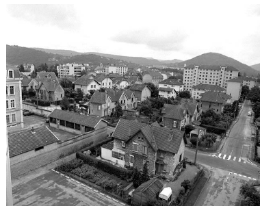
Vue d'ensemble de la cité ouvrière : sud-est. Phot. Yves Sancey IVR43_19932500087X
