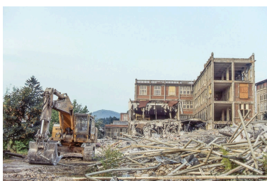
Destruction de l'usine, 19 août 1993 au matin : pelle mécanique et ateliers depuis le nord-est. Phot. Laurent Poupard IVR43_19932500151ZA
