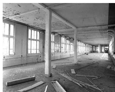
Intérieur d'un atelier de montage (bâtiment 2b, 2e étage). Phot. Yves Sancey IVR43_19932500034X
