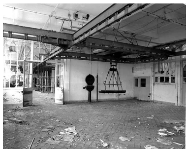
Bascule du monorail et magasin. Phot. Yves Sancey IVR43_19932500028X
