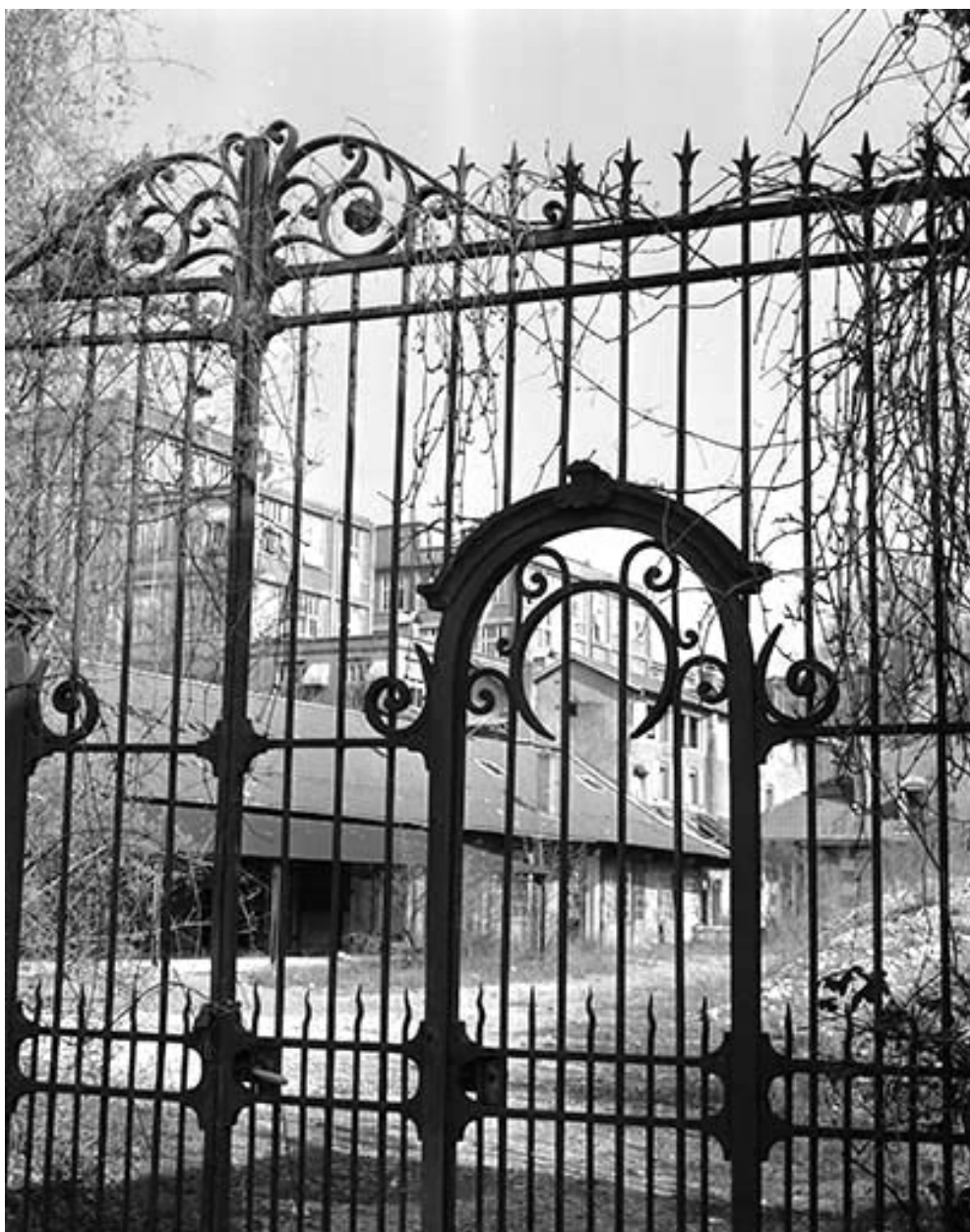
Détail de la grille d'entrée.
