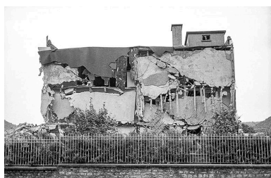
Destruction de l'usine, 22 août 1993 : ateliers (6a, 2a) vus depuis le nord-ouest. Phot. Laurent Poupard IVR43_19932500171Z
