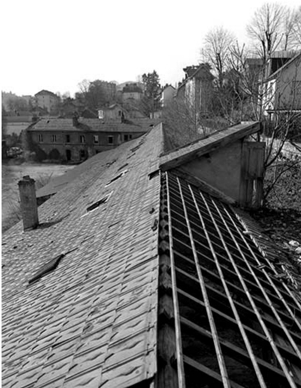
Toiture de la menuiserie.
