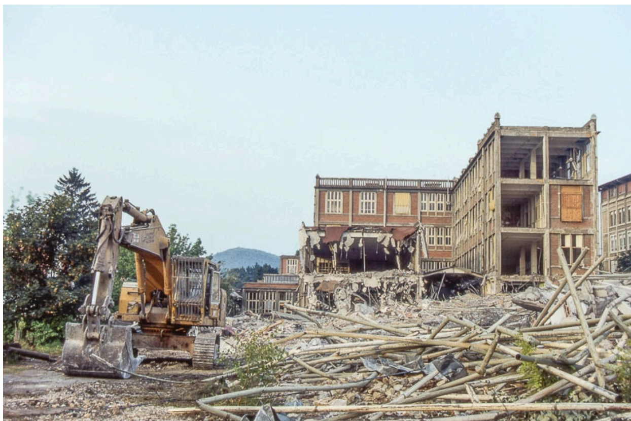
Destruction de l'usine, 19 août 1993 au matin : pelle mécanique et ateliers depuis le nord-est.
