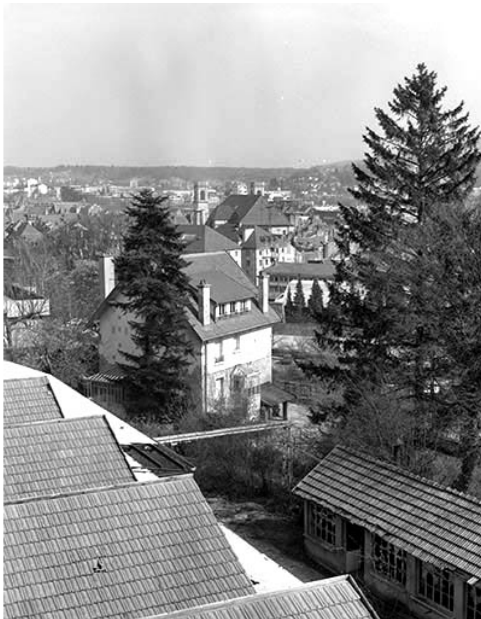
Vue plongeante sur le logement patronal.
