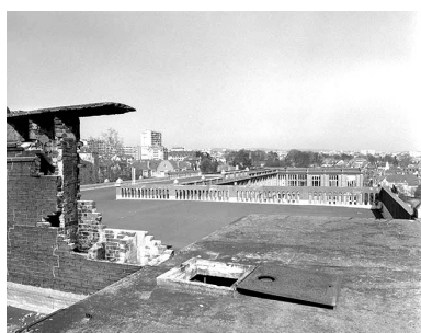
Toit terrasse des bâtiments (6, 8, 9). Phot. Yves Sancey
