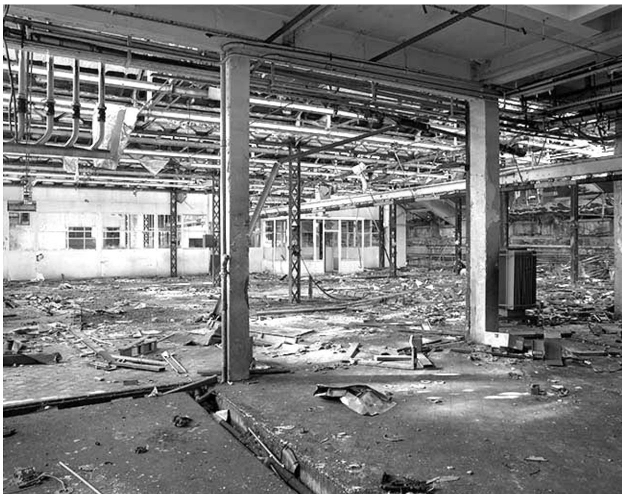
Intérieur du bâtiment (3).
