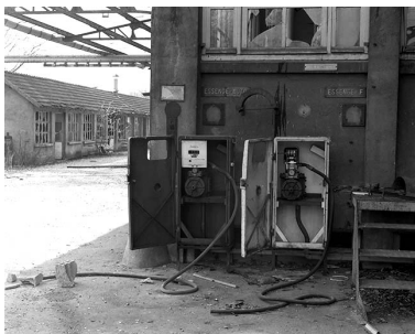
Pompes à essence. Phot. Yves Sancey IVR43_19932500026X
