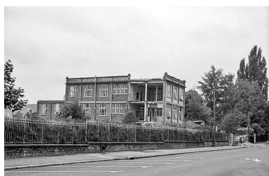
Destruction de l'usine, 23 août 1993 : atelier (2a) vu depuis le nord. Phot. Laurent Poupard IVR43_19932500177Z
