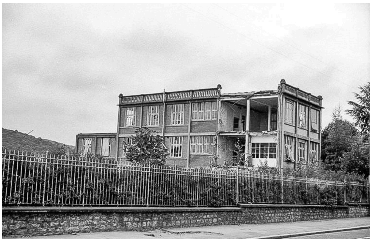
Destruction de l'usine, 22 août 1993 : atelier (2a) vu depuis le nord.
