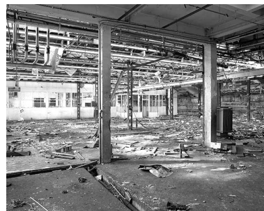
Intérieur du bâtiment (3). Phot. Yves Sancey IVR43_19932500027X
