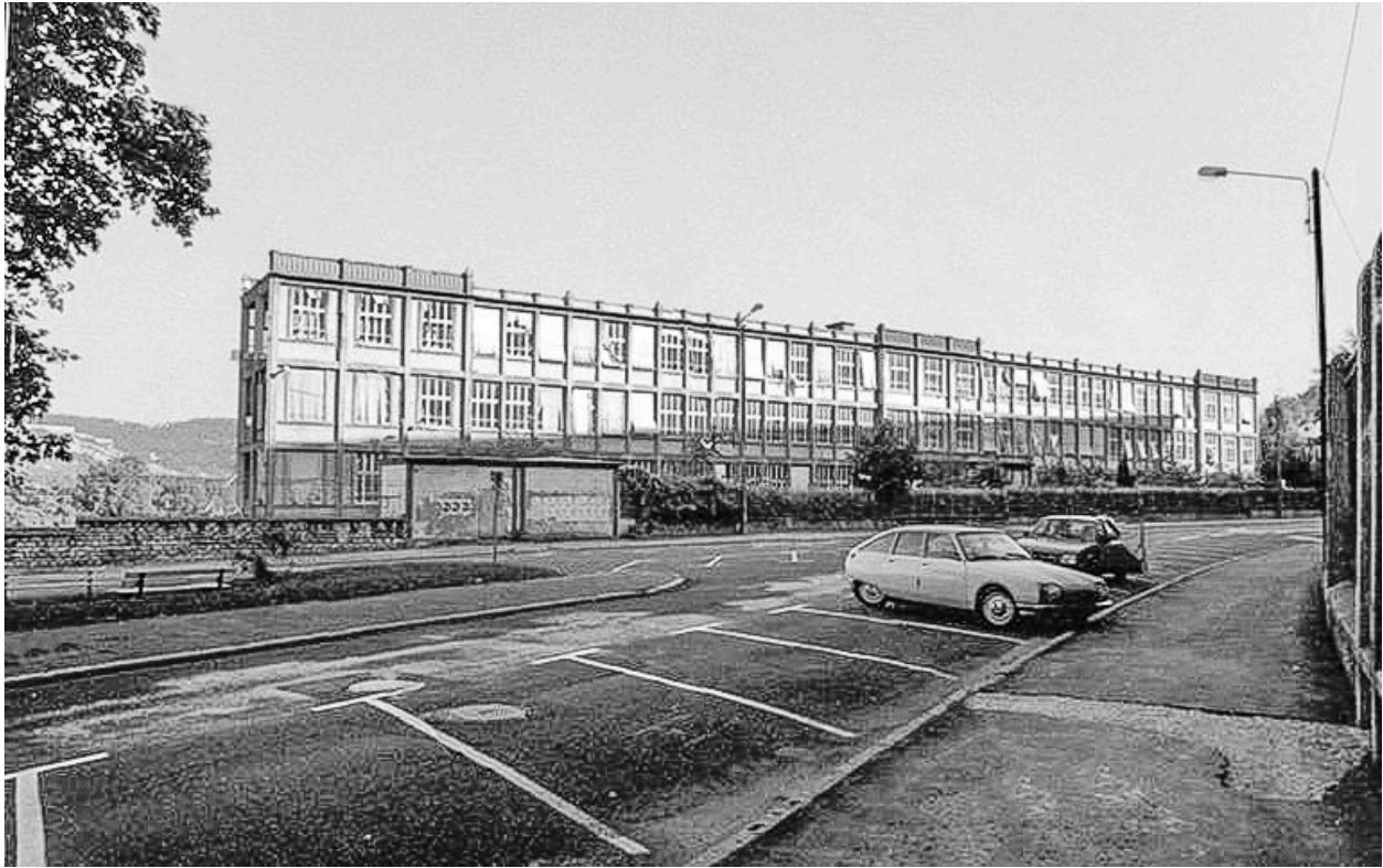
Destruction de l'usine, 22 août 1993 : atelier (6a) vu depuis le nord-est.
