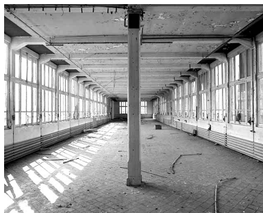
Intérieur d'un atelier de montage (bâtiment 2b, 2e étage). Phot. Yves Sancey IVR43_19932500035X
