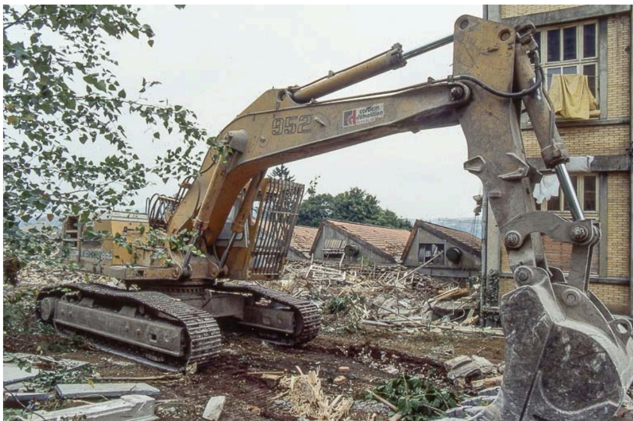
Destruction de l'usine, 23 août 1993 : pelle mécanique.
