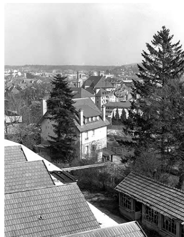
Vue plongeante sur le logement patronal. Phot. Yves Sancey IVR43_19932500049X
