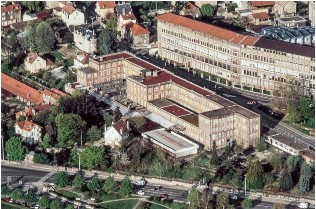
Vue aérienne de l'usine, depuis l'est.
