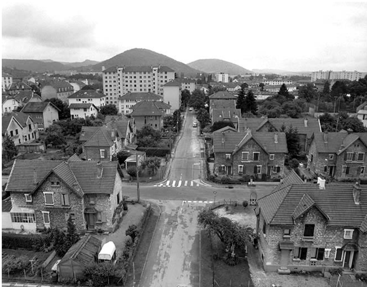
Vue d'ensemble de la cité ouvrière : sud.
