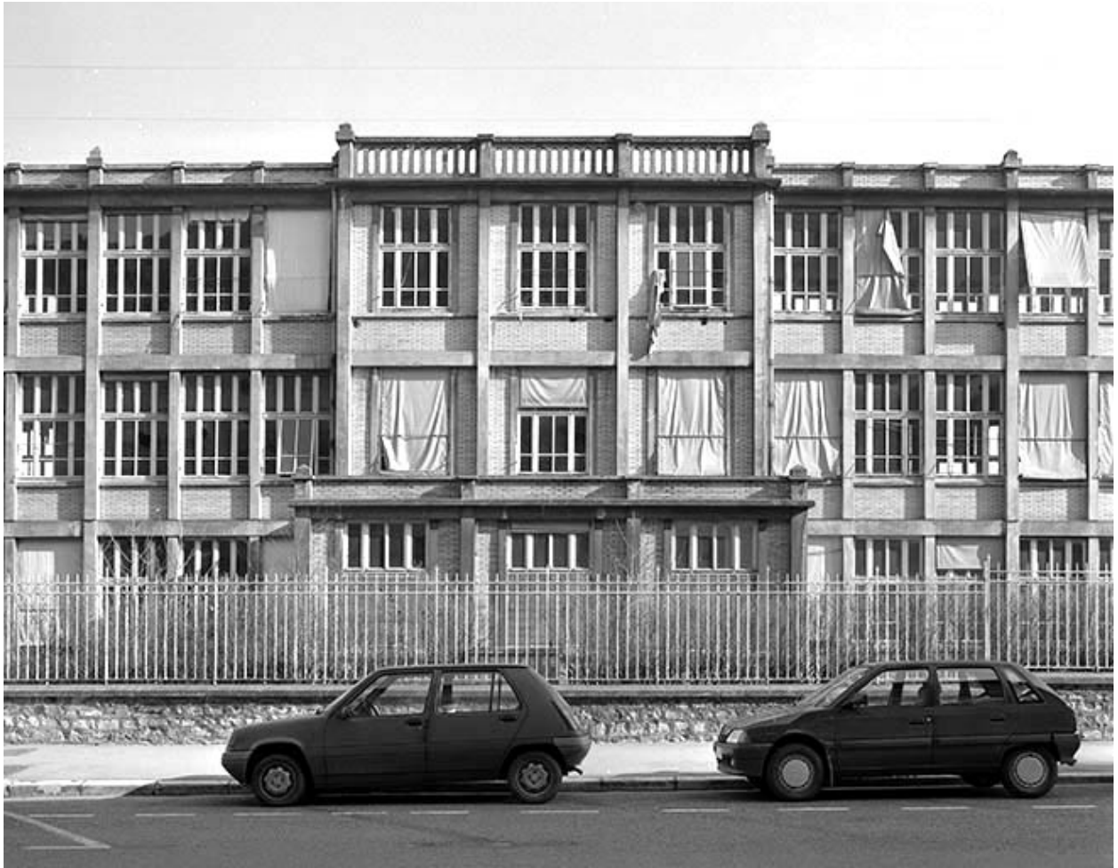
Détail de la façade antérieure (bâtiment 2c).
