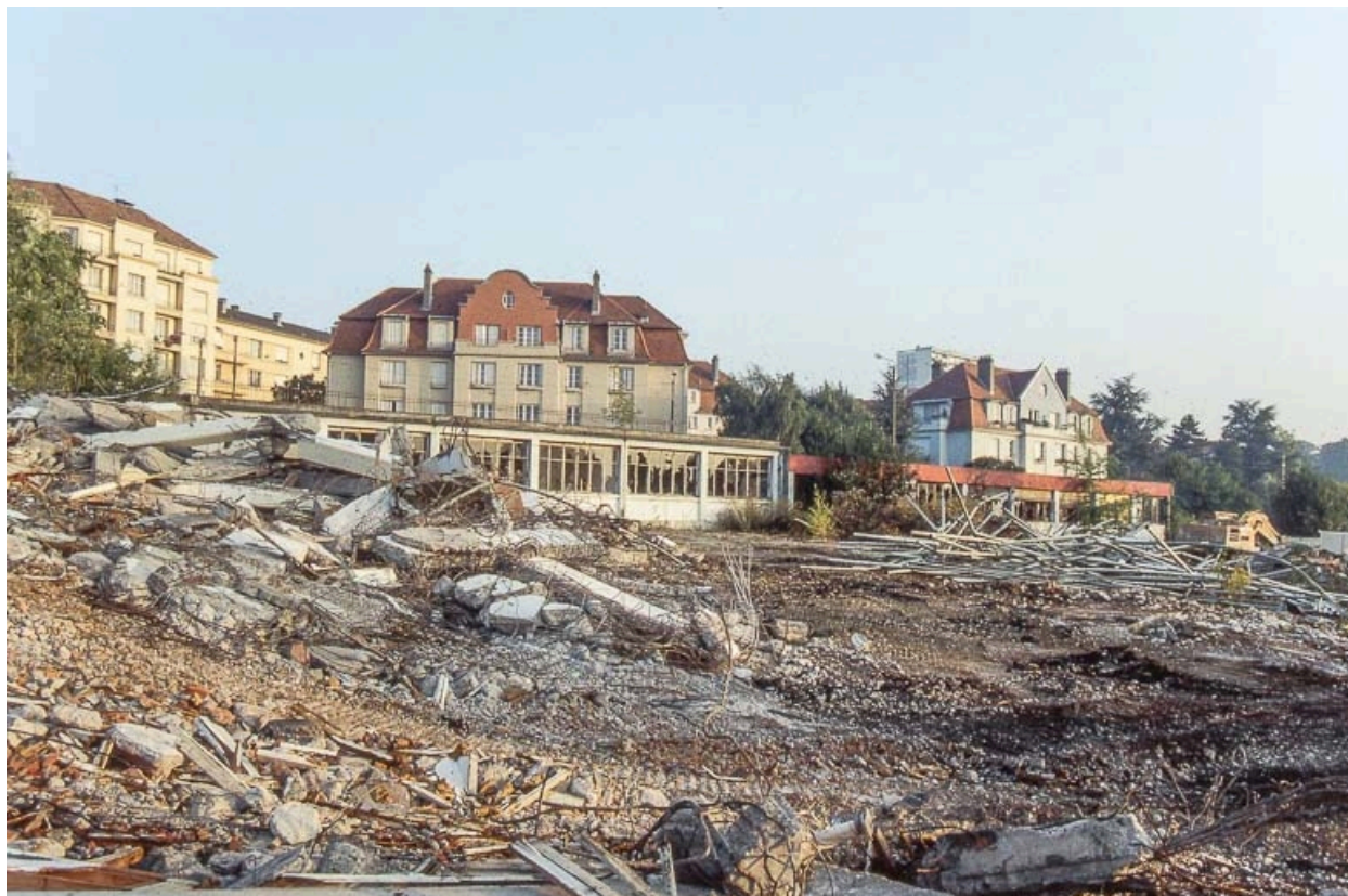
Destruction de l'usine, 25 août 1993 à midi : local syndical et réfectoire.
