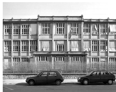
Détail de la façade antérieure (bâtiment 2c). Phot. Yves Sancey IVR43_19932500017X
