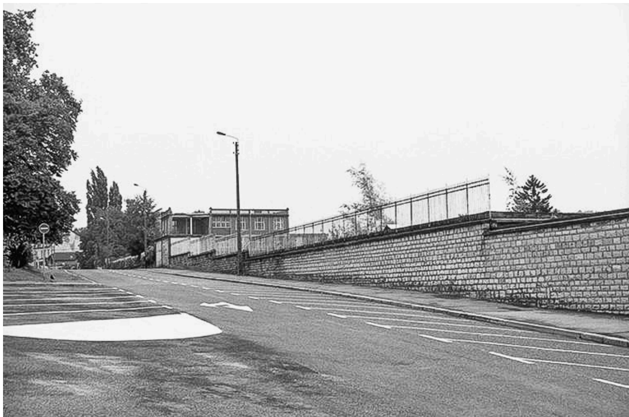
Destruction de l'usine, 23 août 1993 : façade sur l'avenue Villarceau depuis le nord.
