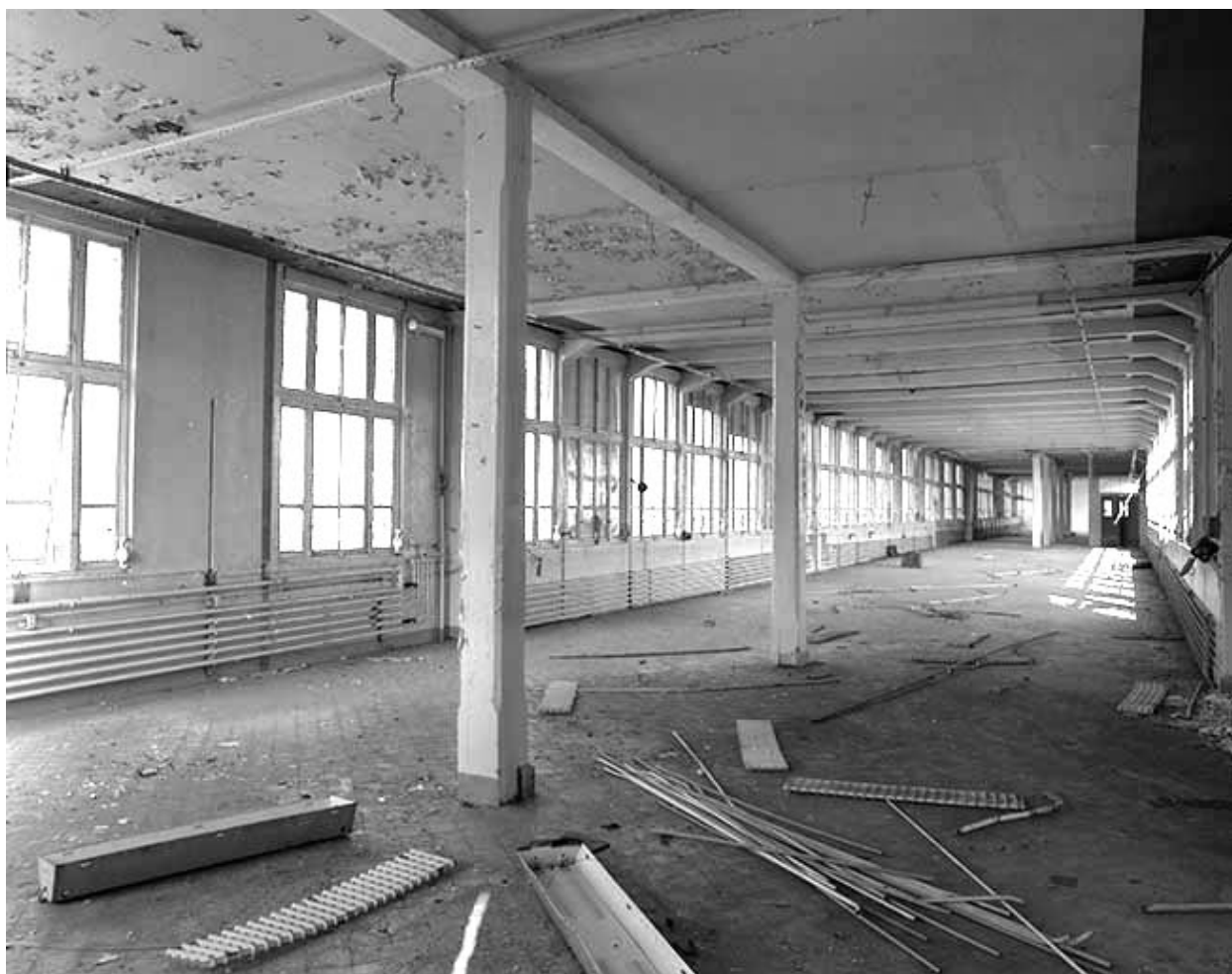
Intérieur d'un atelier de montage (bâtiment 2b, 2e étage).
