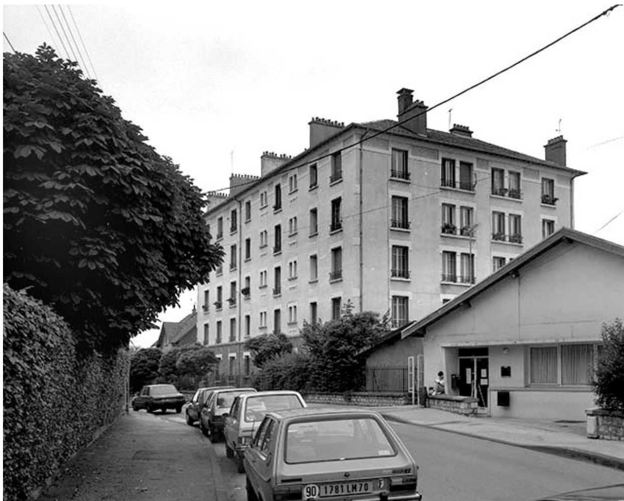
Immeuble, 50 avenue Georges Clémenceau.
