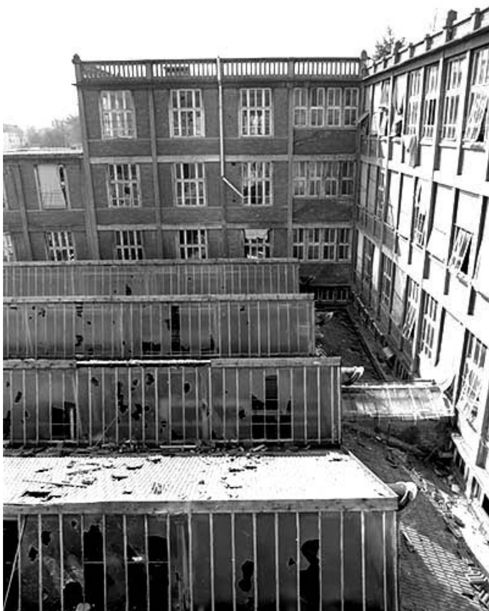
Bâtiment (2a) et sheds du bâtiment (3).
