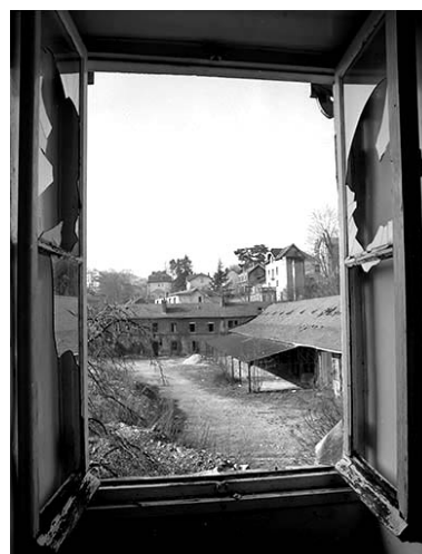
Logement d'ouvriers (21) et menuiserie, depuis une fenêtre du bâtiment (19). Phot. Yves Sancey IVR43_19932500046X
