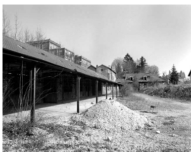
Cour du site ancien. Phot. Yves Sancey IVR43_19932500040X
