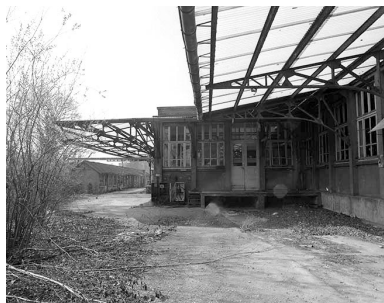
Quai de réception et auvent (bâtiment 6e). Phot. Yves Sancey IVR43_19932500025X
