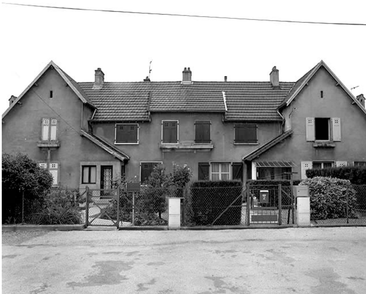
Immeuble de type 1, 2, 4, 6 rue Francis Cussey.
