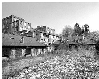
Menuiserie et logement d'ouvriers (19). Phot. Yves Sancey IVR43_19932500041X
