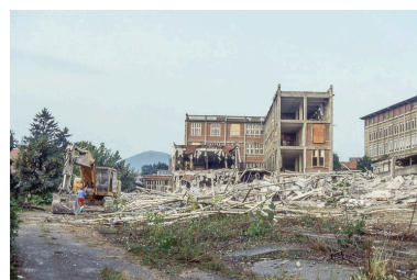
Destruction de l'usine, 19 août 1993 au matin : pelle mécanique et ateliers depuis le nord-est. Phot. Laurent Poupard IVR43_19932500149ZA
