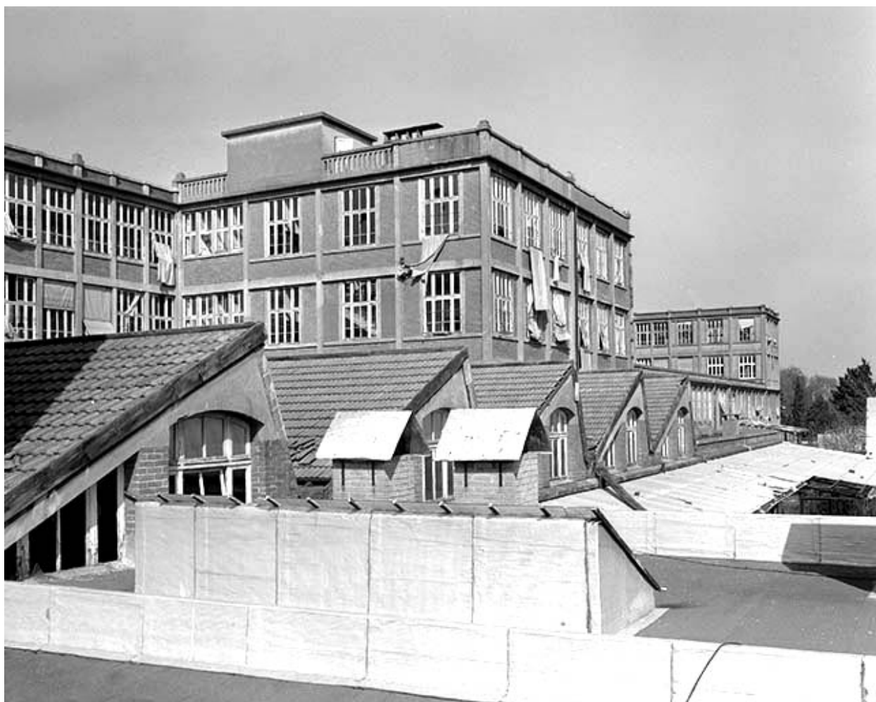
Façade postérieure et sheds.
