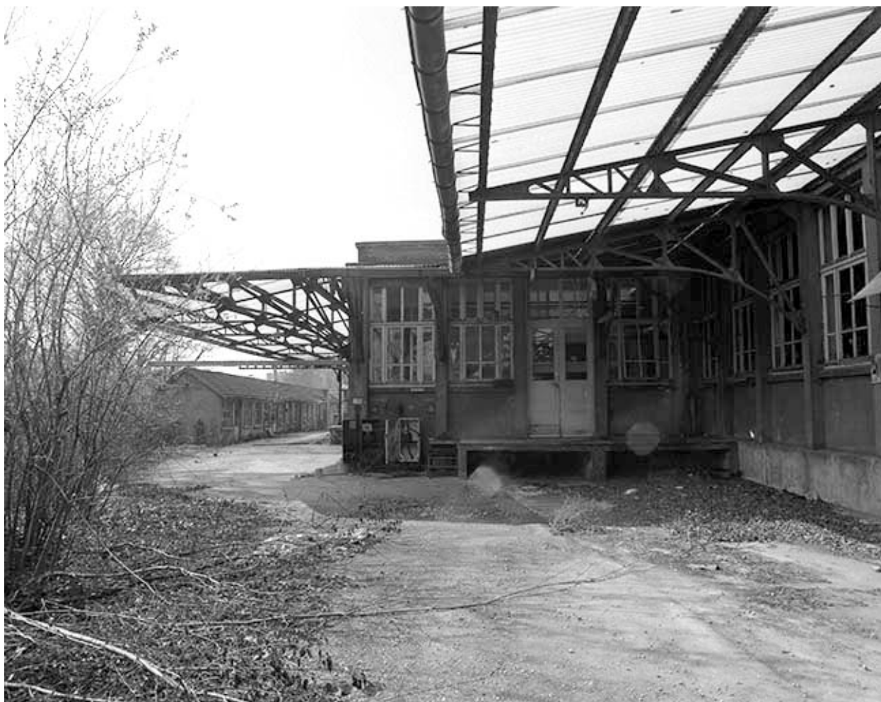
Quai de réception et auvent (bâtiment 6e).
