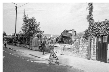
Destruction de l'usine, 24 août 1993 au soir : pelle mécanique et ouvrier. Phot. Laurent Poupard IVR43_19932500183Z
