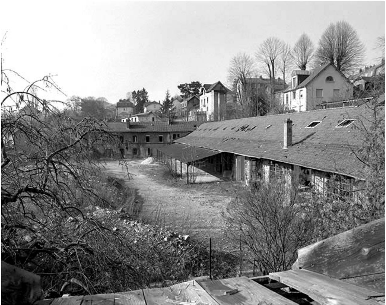
Logement d'ouvriers (21) et menuiserie.
