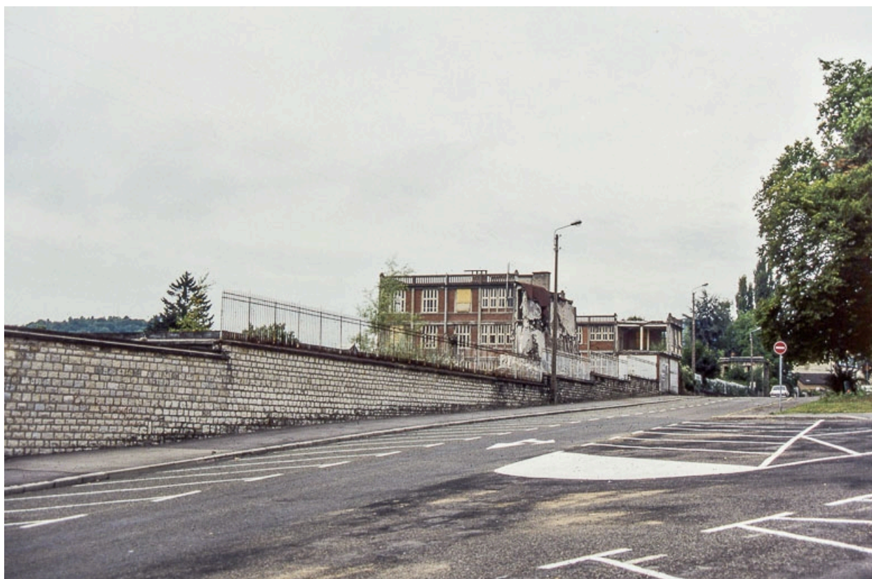
Destruction de l'usine, 22 août 1993 : façade sur l'avenue Villarceau depuis le nord.
