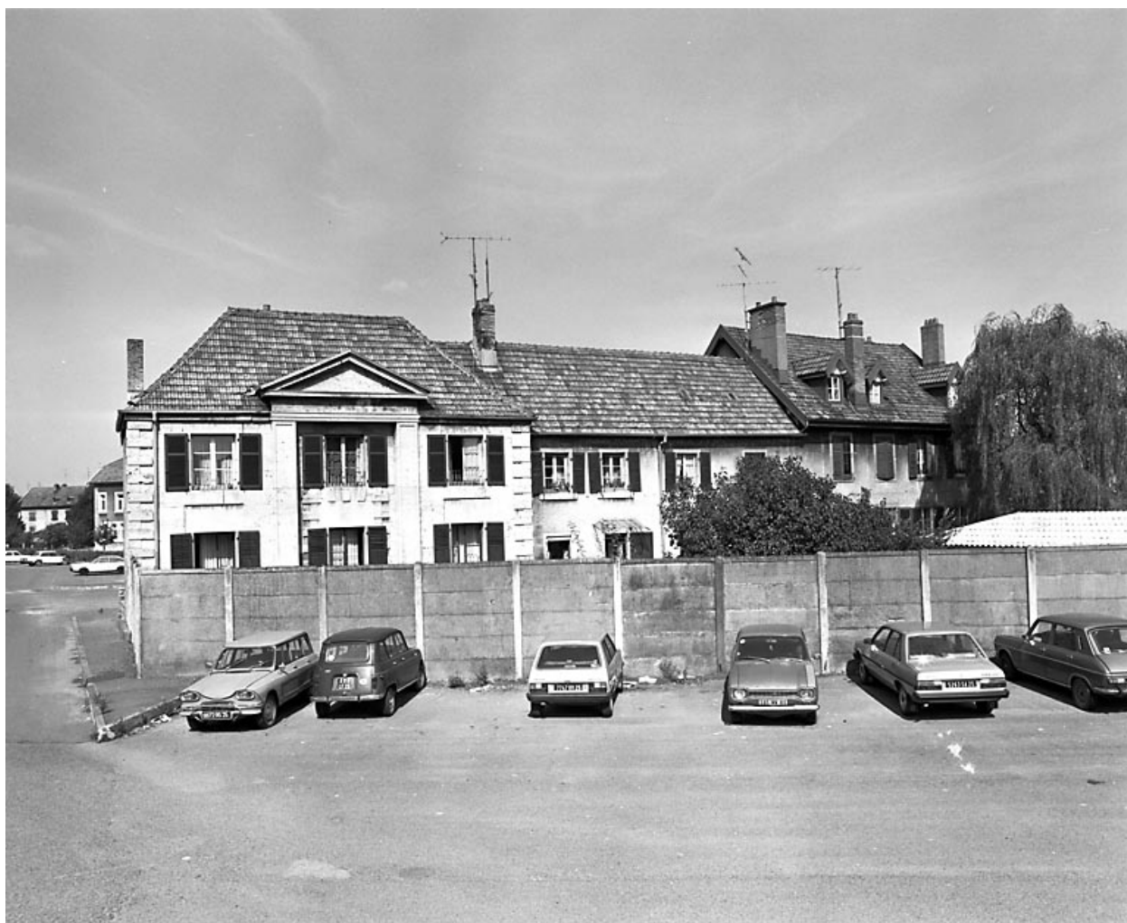
Façade antérieure, cour de l'orangerie.
