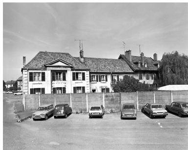
Façade antérieure, cour de l'orangerie. Phot. Yves Sancey IVR43_19812500363X
