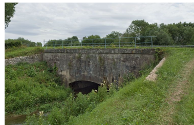
Vue de l'entrée de l'aqueduc. Phot. Pierre-Marie Barbe-Richaud IVR26_20118900345NUC4AQ
