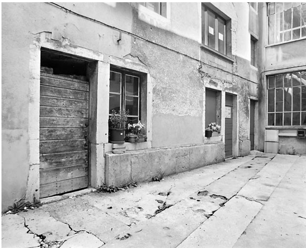
Aile nord : rez-de-chaussée, de trois quarts gauche.
