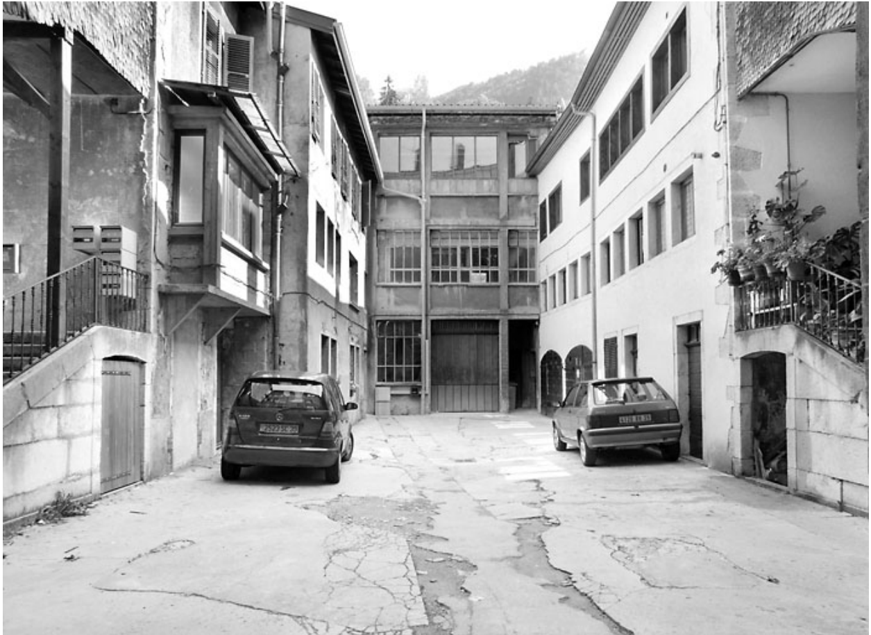
Vue d'ensemble des bâtiments dans la cour.
