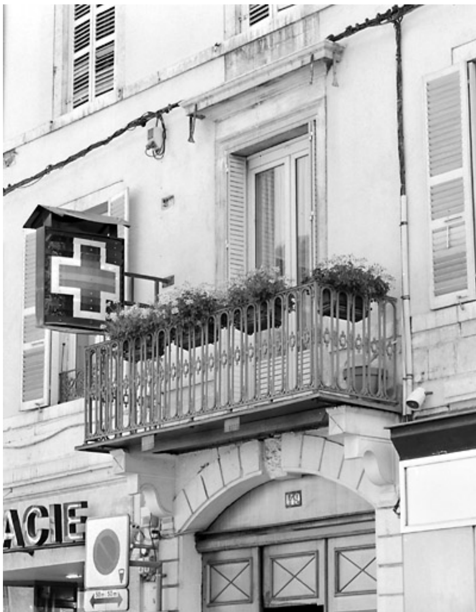
Porte-fenêtre du premier étage et balcon.
