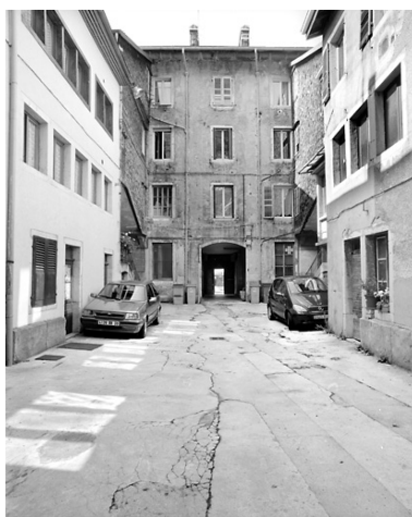
Façade postérieure et cour. Phot. Yves Sancey IVR43_20033900737X
