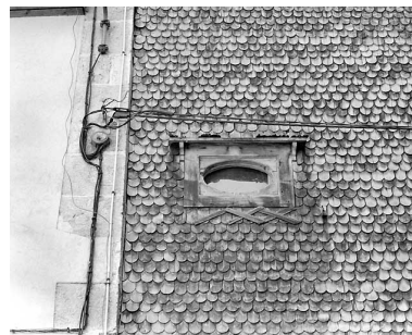
Escalier sud : oculus et tavaillons (bardeaux). Phot. Yves Sancey IVR43_20033900742X
