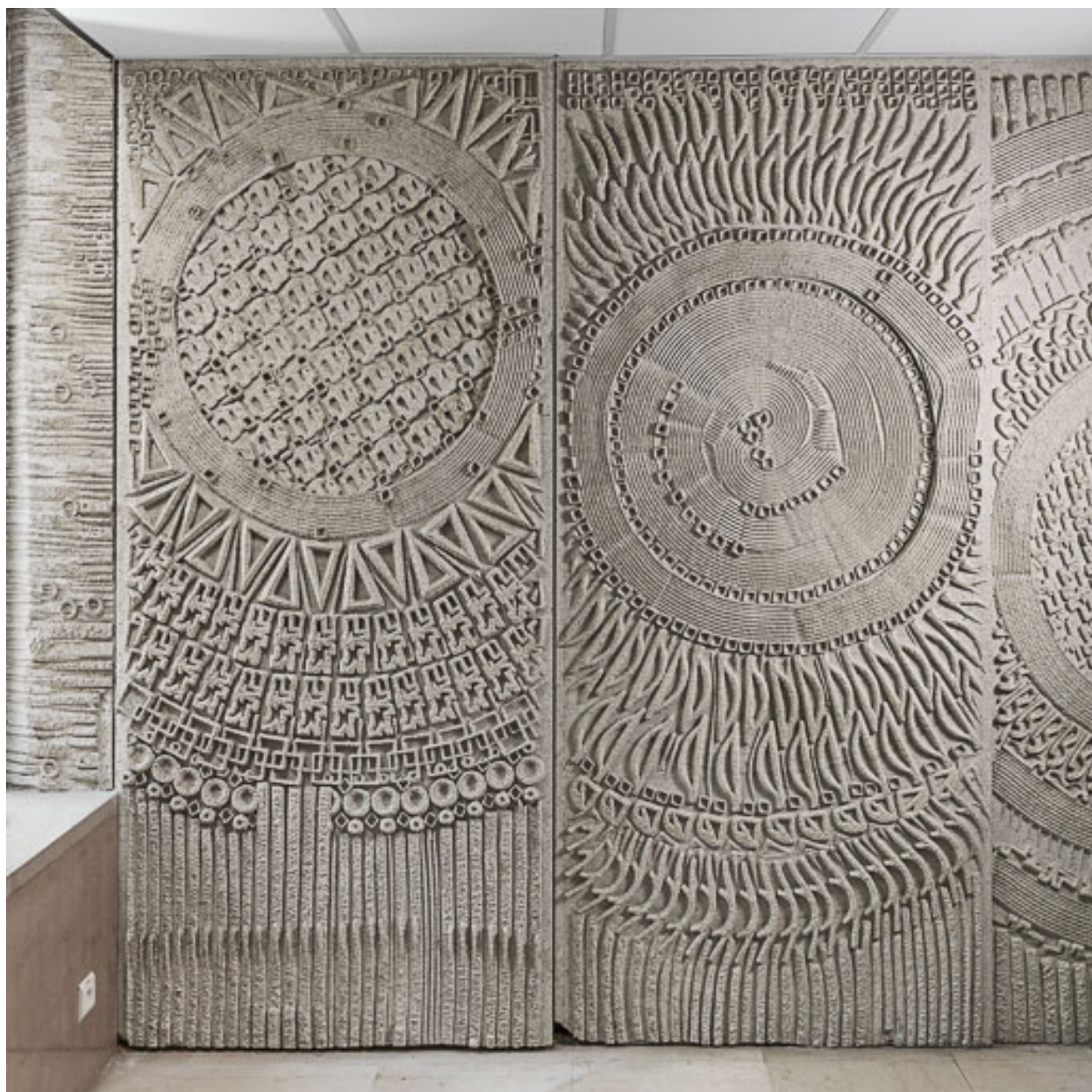
Hall d'accueil : panneaux moulés de la mezzanine.
