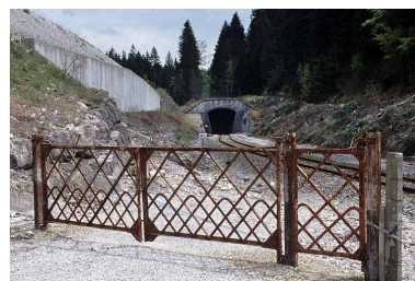
Vue d'ensemble. Phot. Yves Sancey IVR43_20053900303ZA
