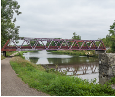
Vue du pont.
