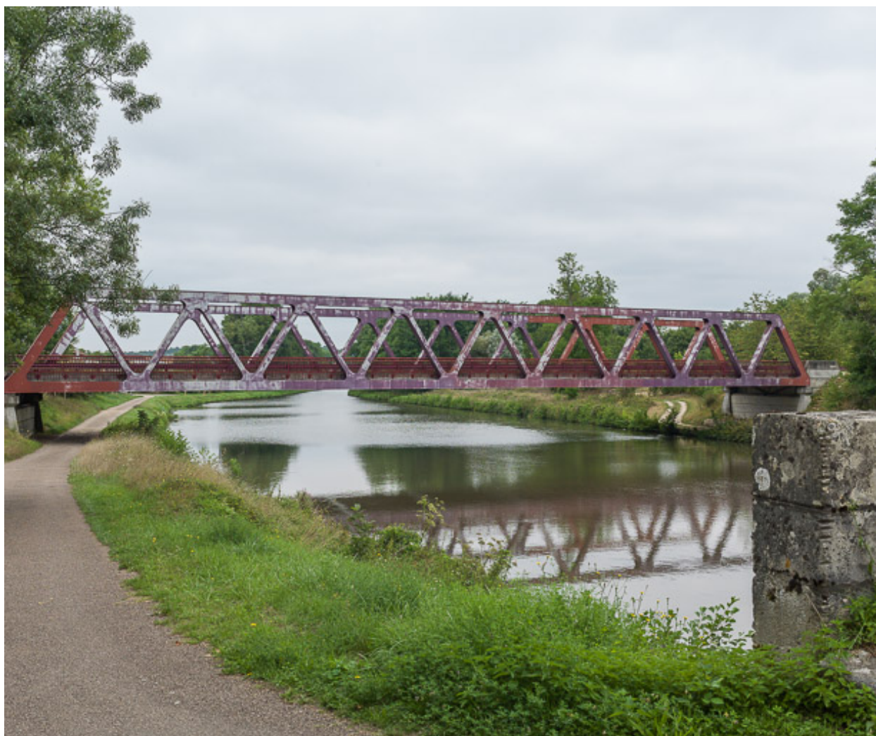
Vue du pont.
