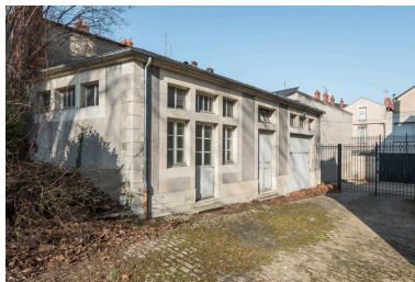
Façade sur la cour. Phot. Pierre-Marie Barbe-Richaud IVR26_20235800020NUC4A
