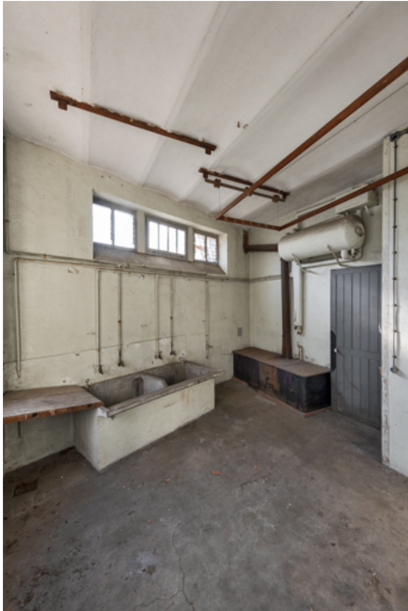
Vue intérieure de la buanderie.
