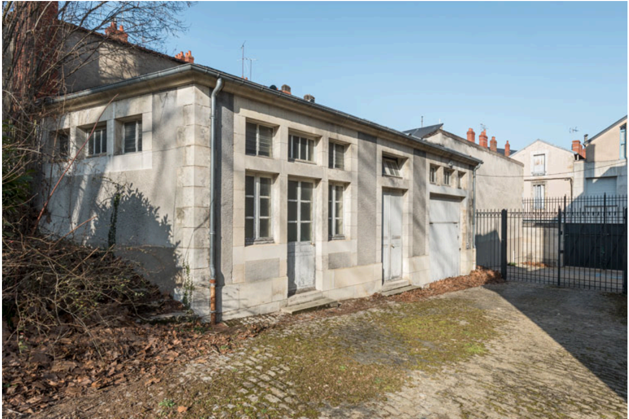
Façade sur la cour.
