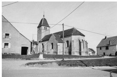
Façade latérale droite. Phot. Bernard Lardière IVR43_19817000293Z
