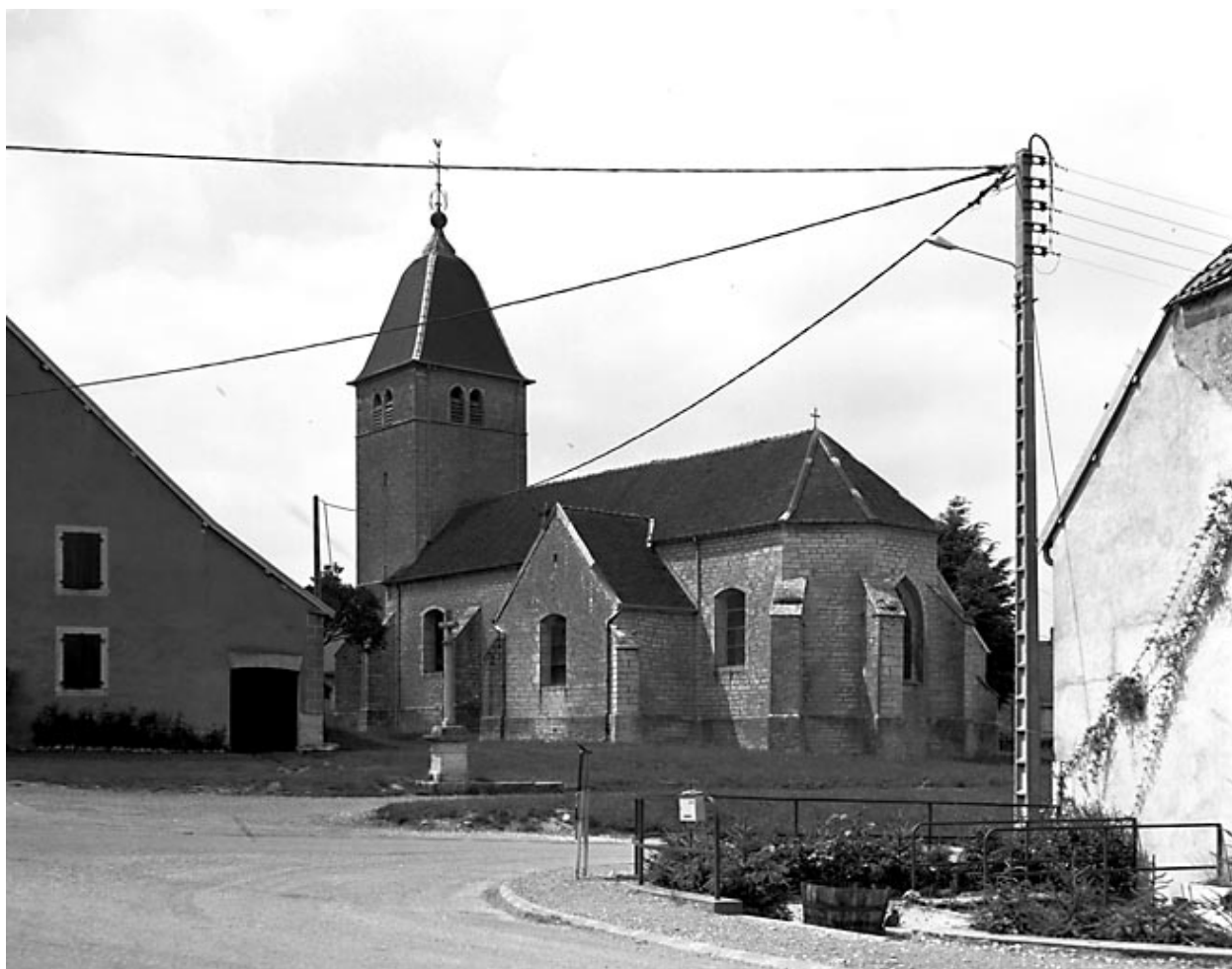
Chevet et façade latérale droite.
