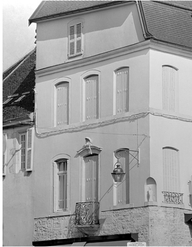
Élévation sur la rue du Commerce. Phot. Yves Sancey IVR43_19853900318X
