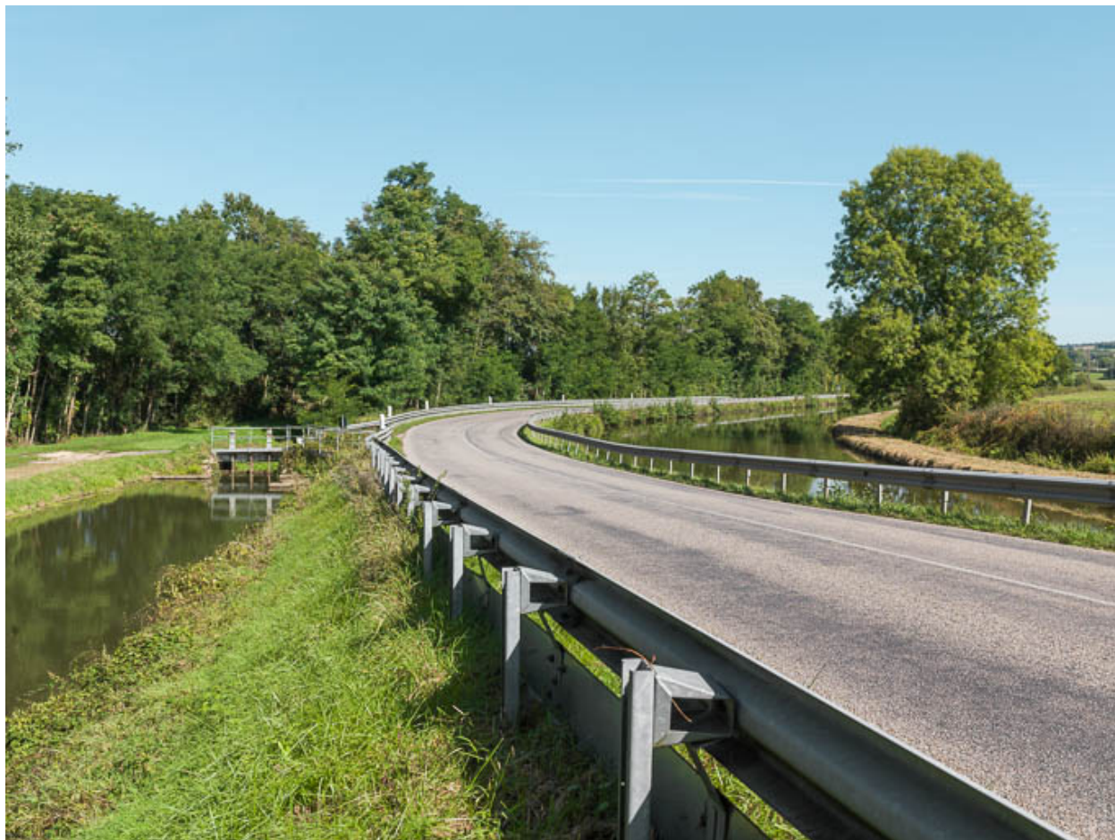
Vue du petit barrage à deux vannes.
