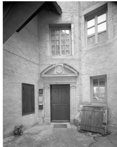
Détail : porte d'entrée de l'escalier en vis. Phot. Yves Sancey IVR43_19897000237V
