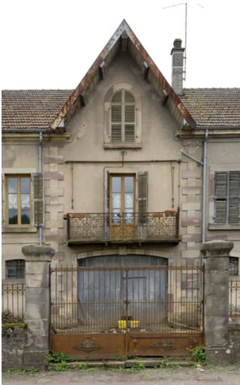
Façade antérieure. Pignon central.
