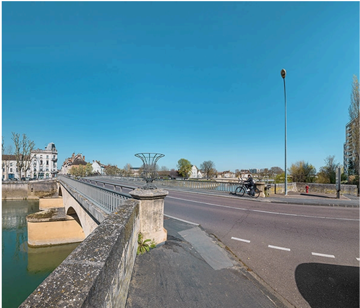
Vue d'ensemble du pont depuis la chaussée.
