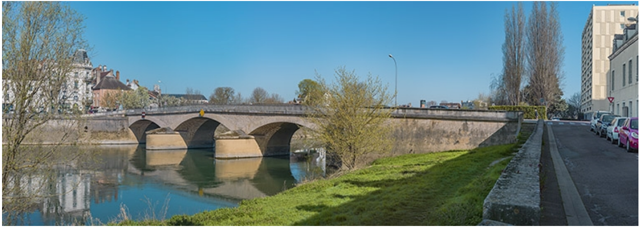
Vue d'ensemble, d'aval.
