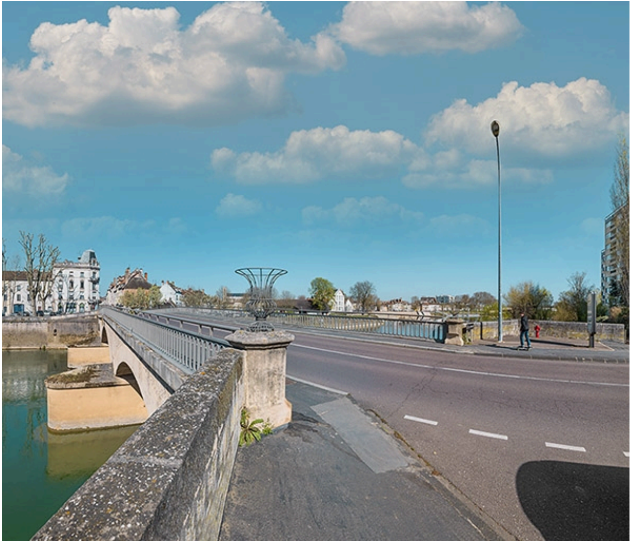
Vue d'ensemble du pont depuis la chaussée.
