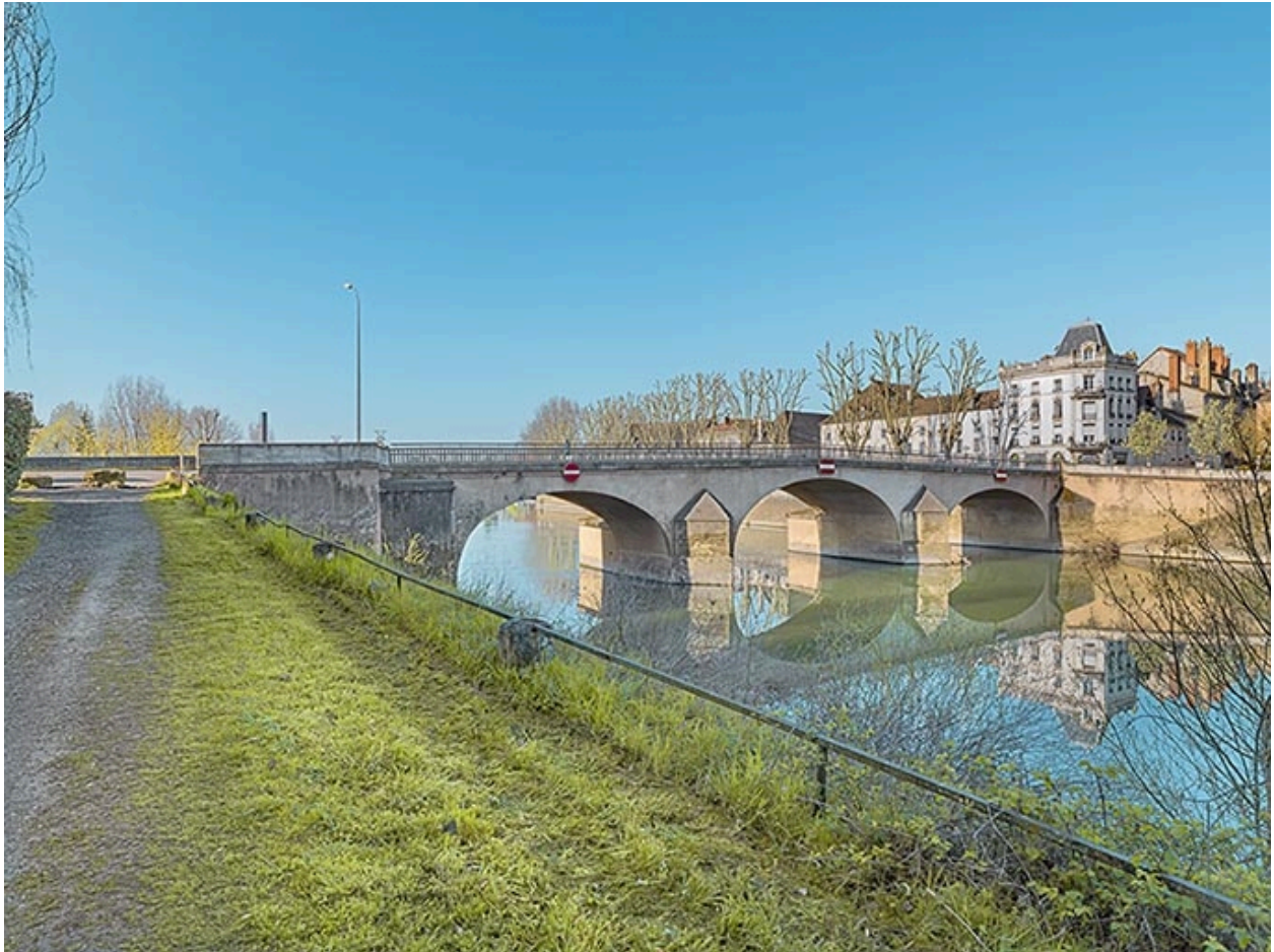
Vue d'ensemble du pont.
