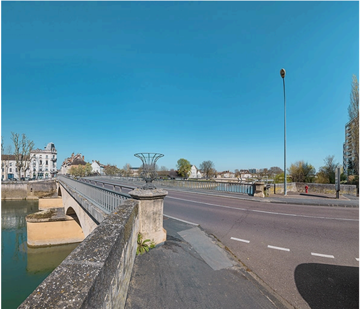
Vue d'ensemble du pont depuis la chaussée.
