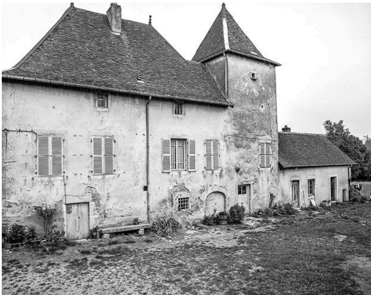
Demeure située au lieudit La Grange Rouge.
