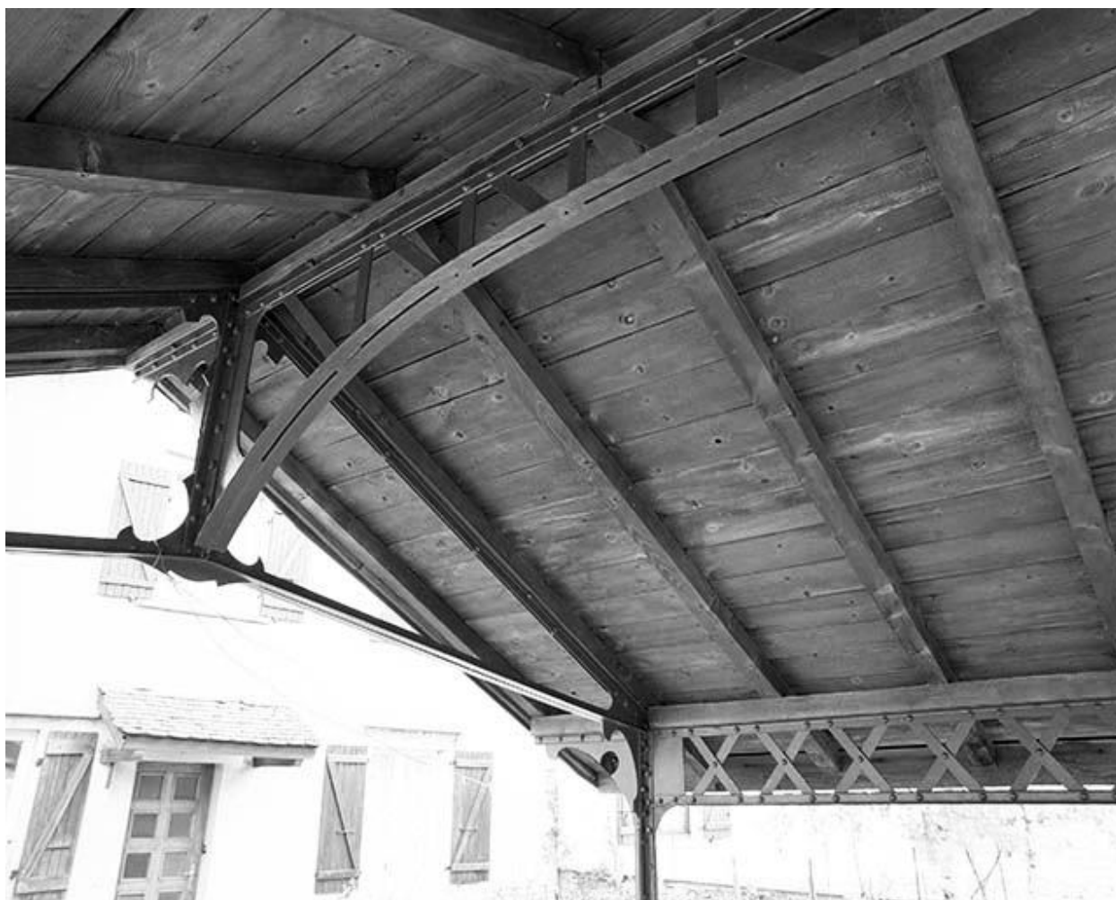
Charpente métallique : faîtage et sablière.
