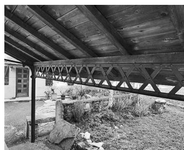
Détail de la panne sablière. Phot. Yves Sancey IVR43_19993900270X
