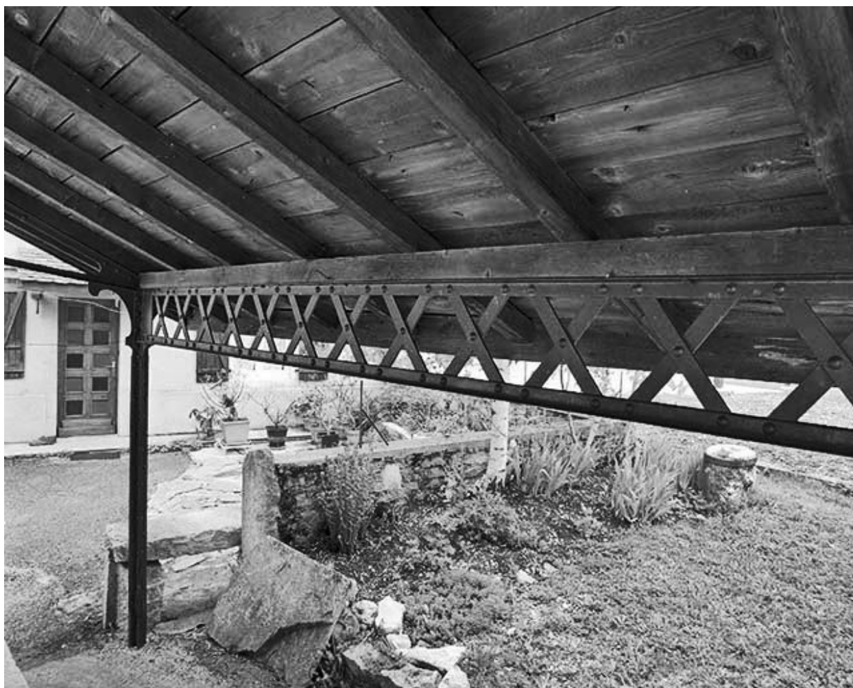
Détail de la panne sablière.
