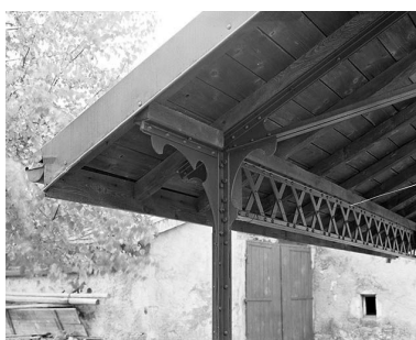
Raccord de la panne sablière et d'un potelet métallique. Phot. Yves Sancey IVR43_19993900273X
