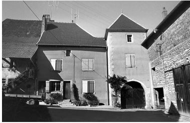
Vue d'ensemble. Phot. Bernard Lardière IVR43_19797000398Z
