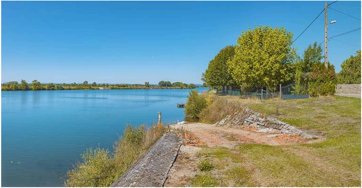
Rampe et perrés au port d'Ouroux.
