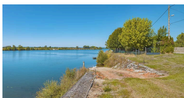
Rampe et perrés au port d'Ouroux.
