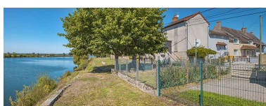
Cale double à tablier haut du port d'Ouroux.
