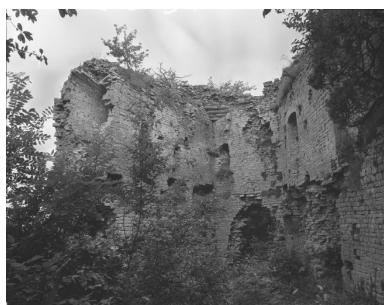
Vue intérieure du donjon montrant le passage à l'intérieur du mur. Phot. Yves Sancey IVR43_19833900755X
