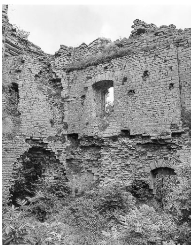
Vue intérieure du donjon : détail. Phot. Yves Sancey IVR43_19833900757X
