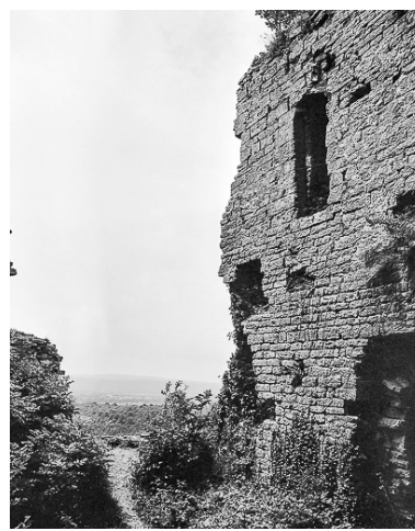
Vue extérieure du donjon et panorama. Phot. Yves Sancey IVR43_19833900758X
