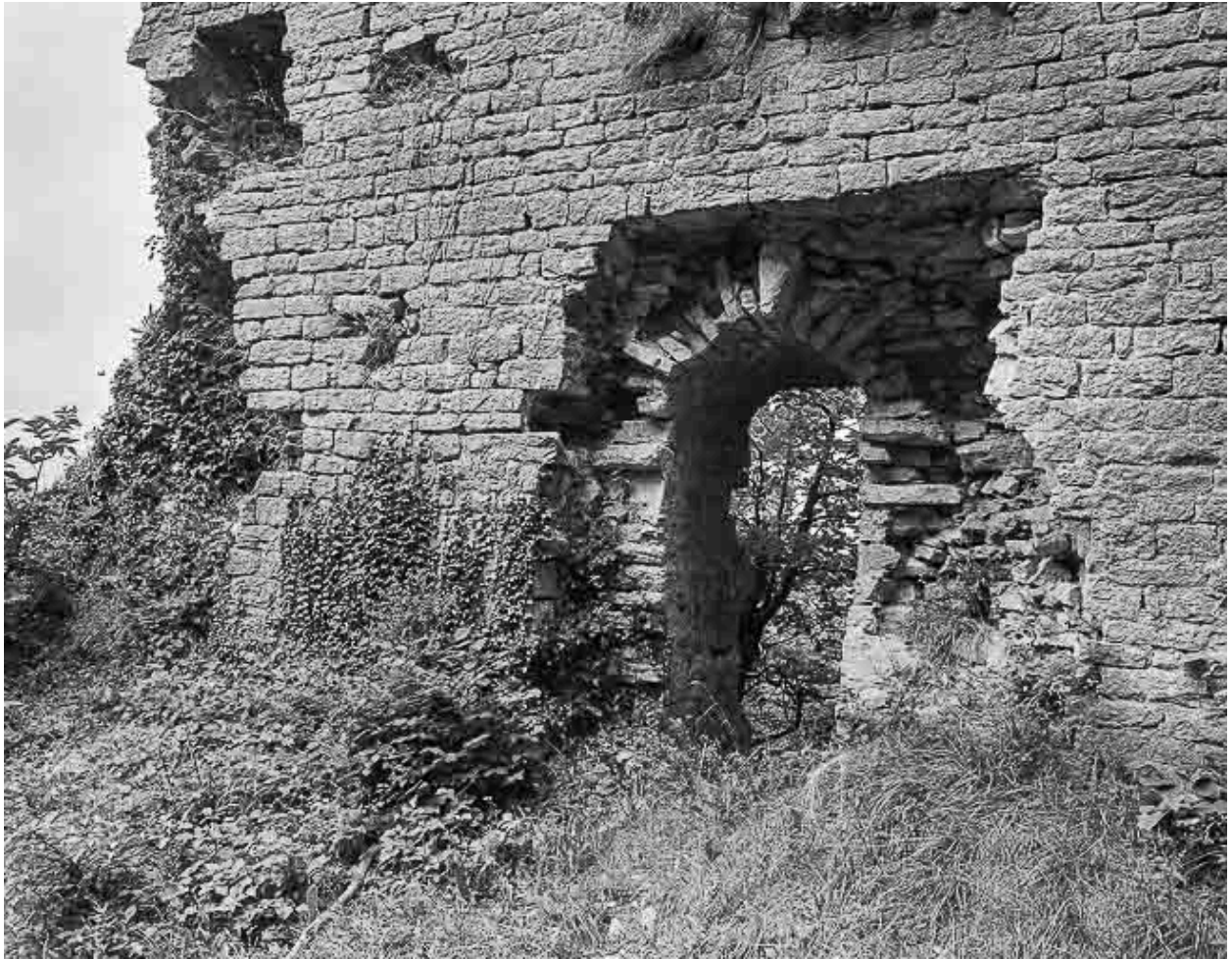
Vue extérieure du donjon : détail d'une porte.
