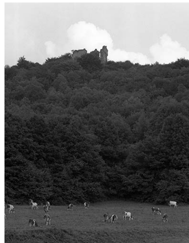
Vue de situation. Phot. Yves Sancey IVR43_19813900308X
