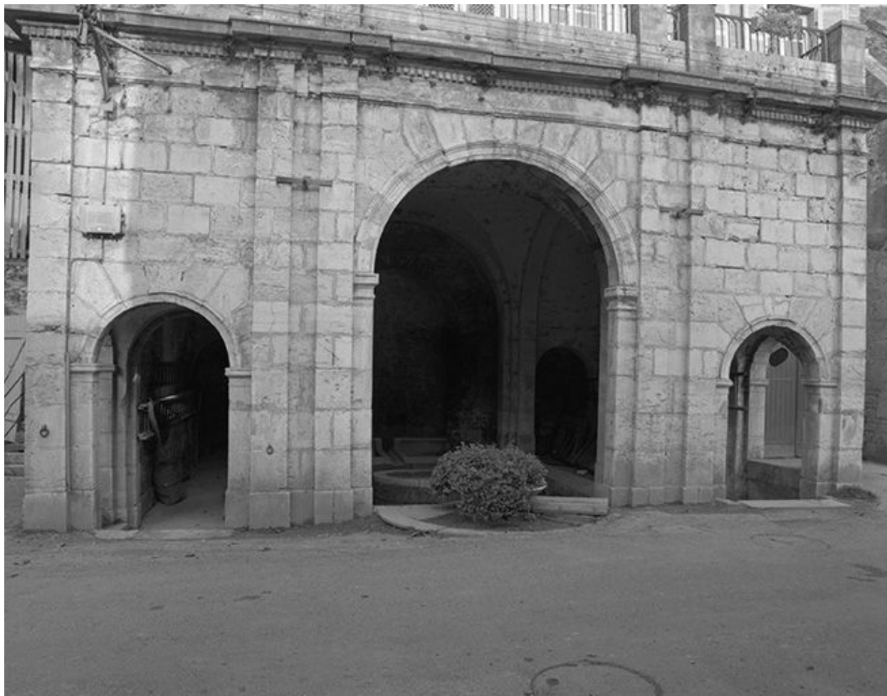
Façade antérieure : détail du rez-de-chaussée.
