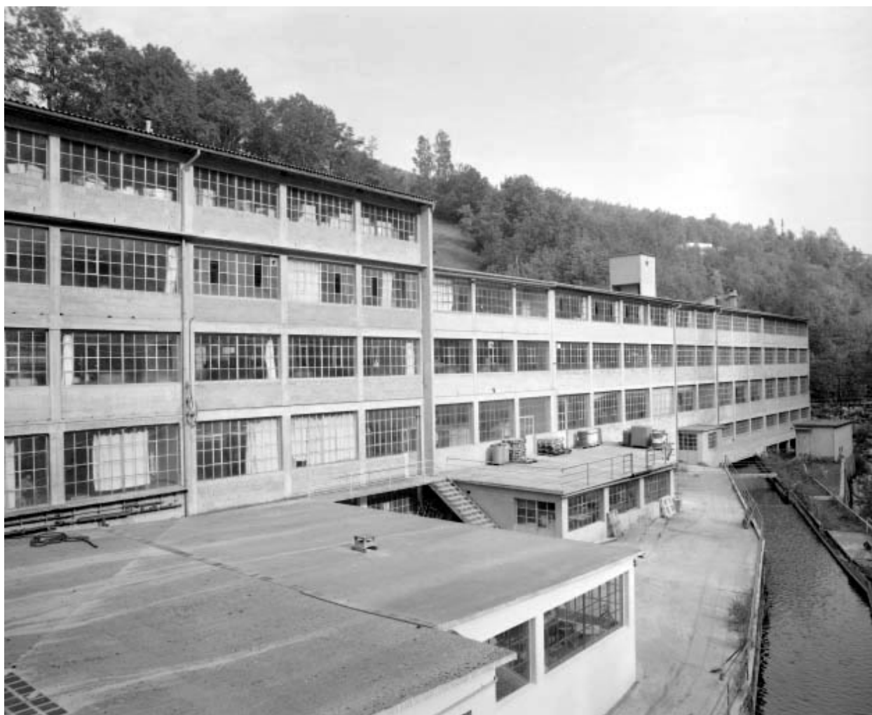
Façade postérieure des ateliers de fabrication.
