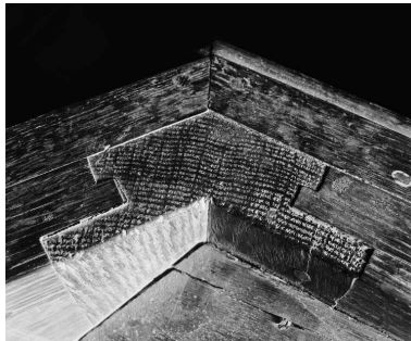
Détail de l'assemblage du bâti de la cuve. Phot. Michel Rosso IVR26_19792100551X
