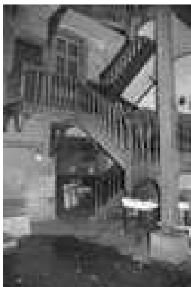
Immeuble : détail de l'escalier sur cour et de la porte d'accès à la cour. Phot. Yves Sancey IVR43_19982500023Z
