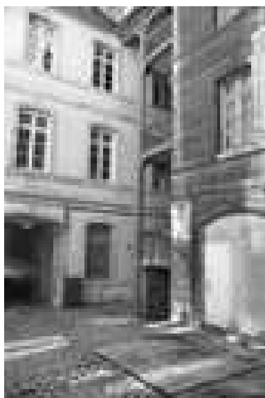
Hôtel et immeuble : escalier droit sur cour : de trois quarts droit. Phot. Yves Sancey IVR43_19982500011Z
