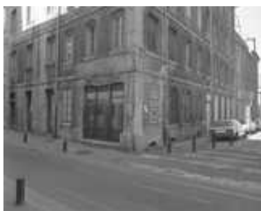
Immeuble : vue d'ensemble depuis l'angle des rues Jean Petit et Courbet.
