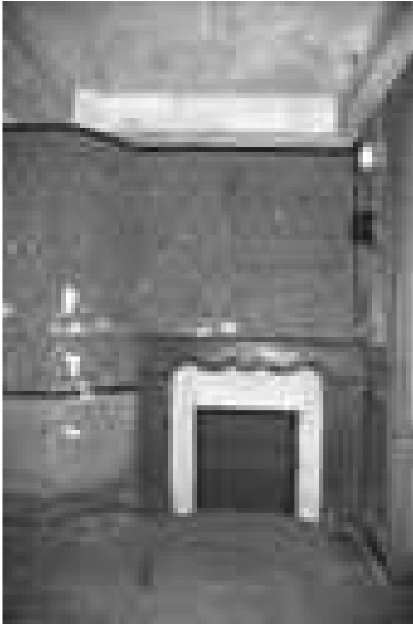
Immeuble : intérieur, détail d'une cheminée du premier étage, de face.
