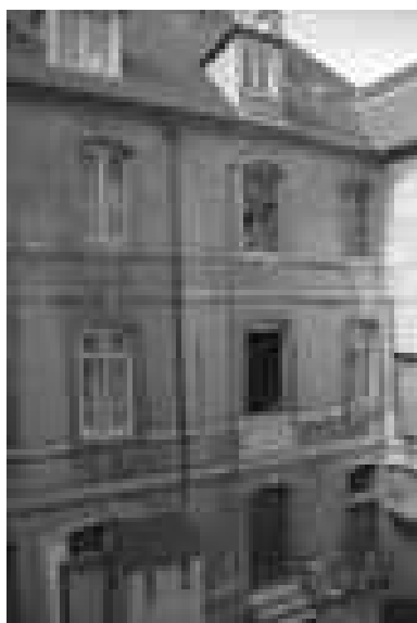
Hôtel et immeuble : détail de la façade sur cour du logis secondaire donnant place Paris.
