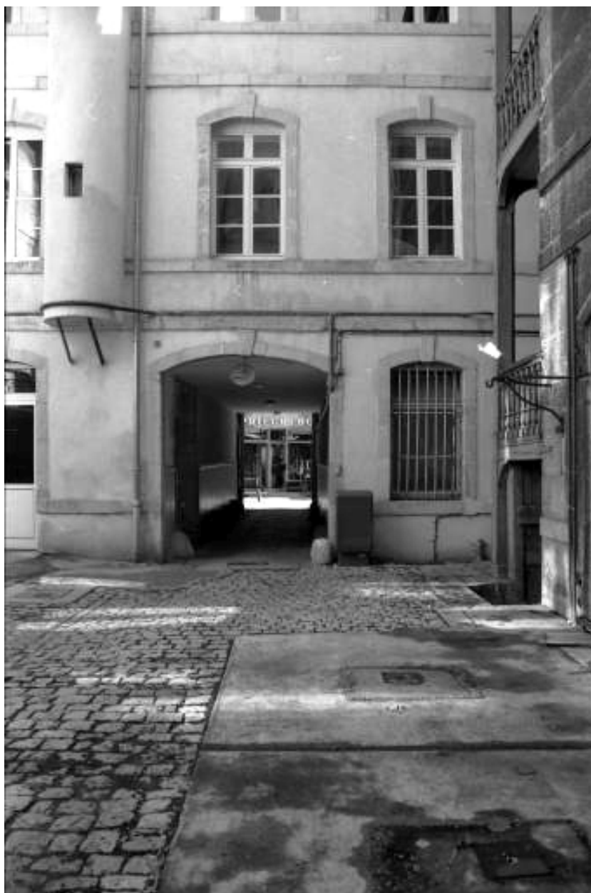
Hôtel et immeuble : façade postérieure du logis principal sur cour : détail partie droite.
