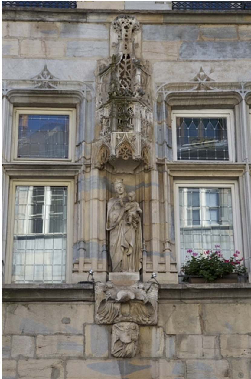
Maison de ville de l'abbaye de la Charité, façade antérieure : détail de la niche, vue rapprochée.
