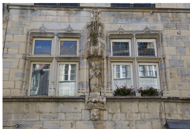
Maison de ville de l'abbaye de la Charité, façade antérieure : détail de la niche. Phot. Yves Sancey IVR43_20122501708NUC2A
