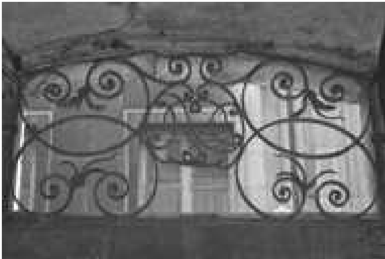
Immeuble : détail de la ferronnerie de l'imposte de la porte d'entrée.
