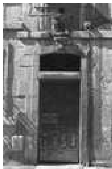
Immeuble : détail de la porte d'entrée.
