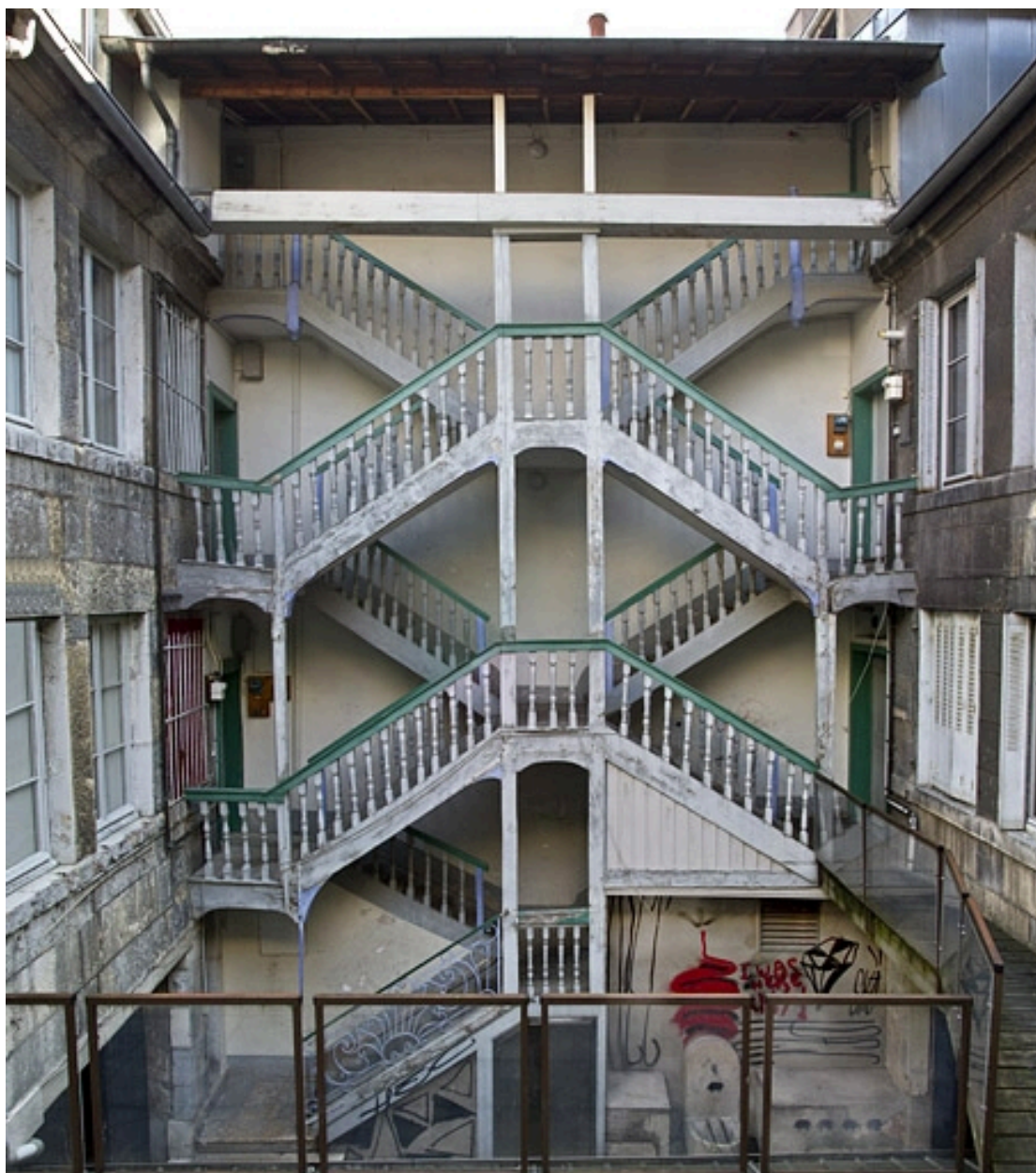
Maison : vue d'ensemble de l'escalier à cage ouverte.
