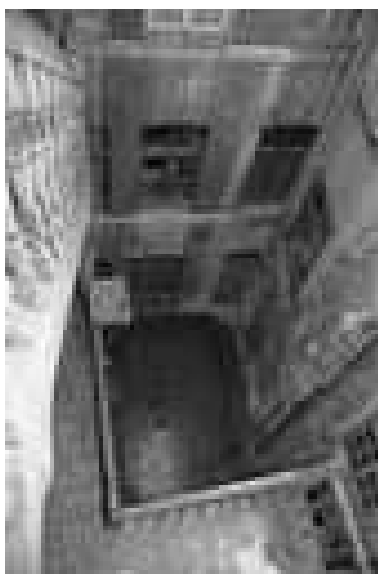
Immeuble : détail de la cour depuis le haut de l'escalier extérieur. Phot. Yves Sancey IVR43_19982500015Z
