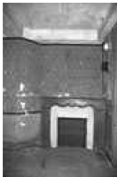
Immeuble : intérieur, détail d'une cheminée du premier étage, de face. Phot. Yves Sancey IVR43_19982500028Z
