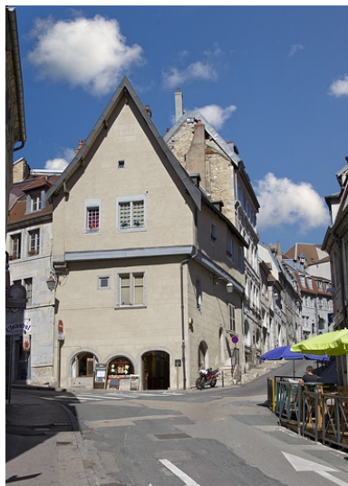
Maison : vue d'ensemble. Phot. Yves Sancey IVR43_20122501712NUC2A
