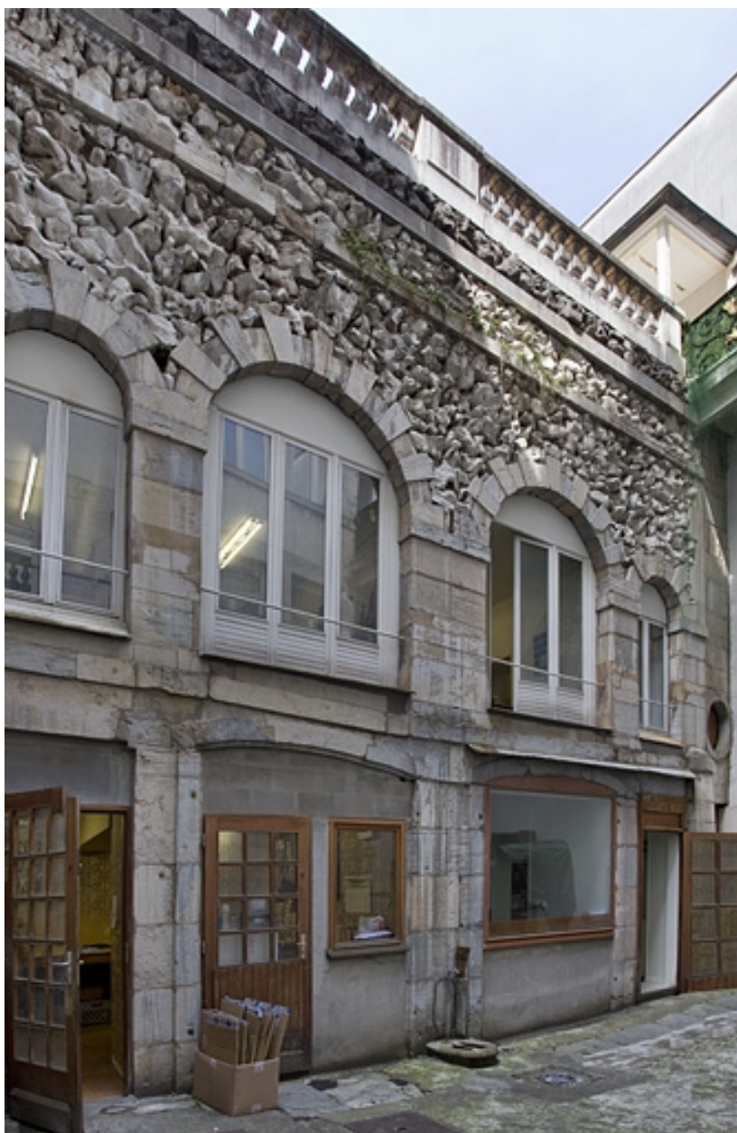
Maison de l'architecte Marnotte : vue du bâtiment des remises et écurie : de trois quarts gauche.
