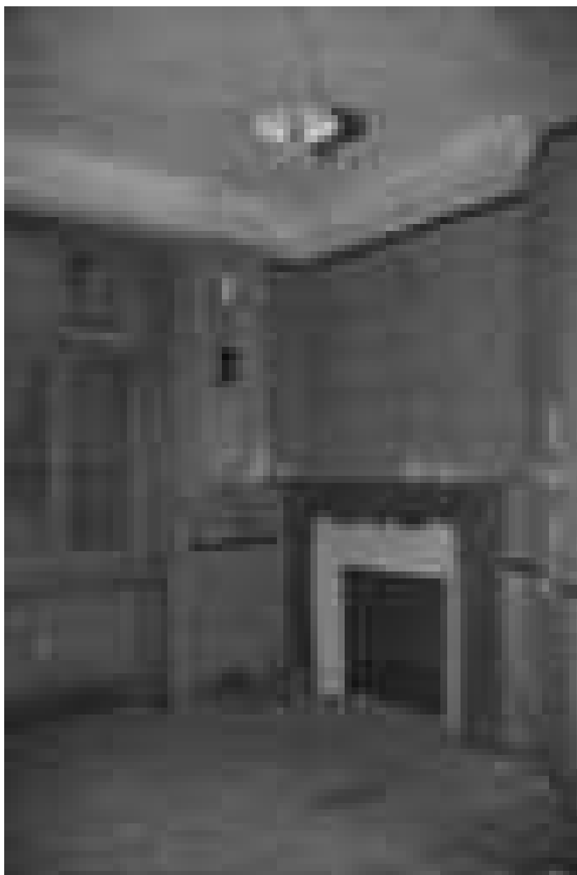
Immeuble, intérieur : détail d'une cheminée du premier étage, de trois quarts gauche.
