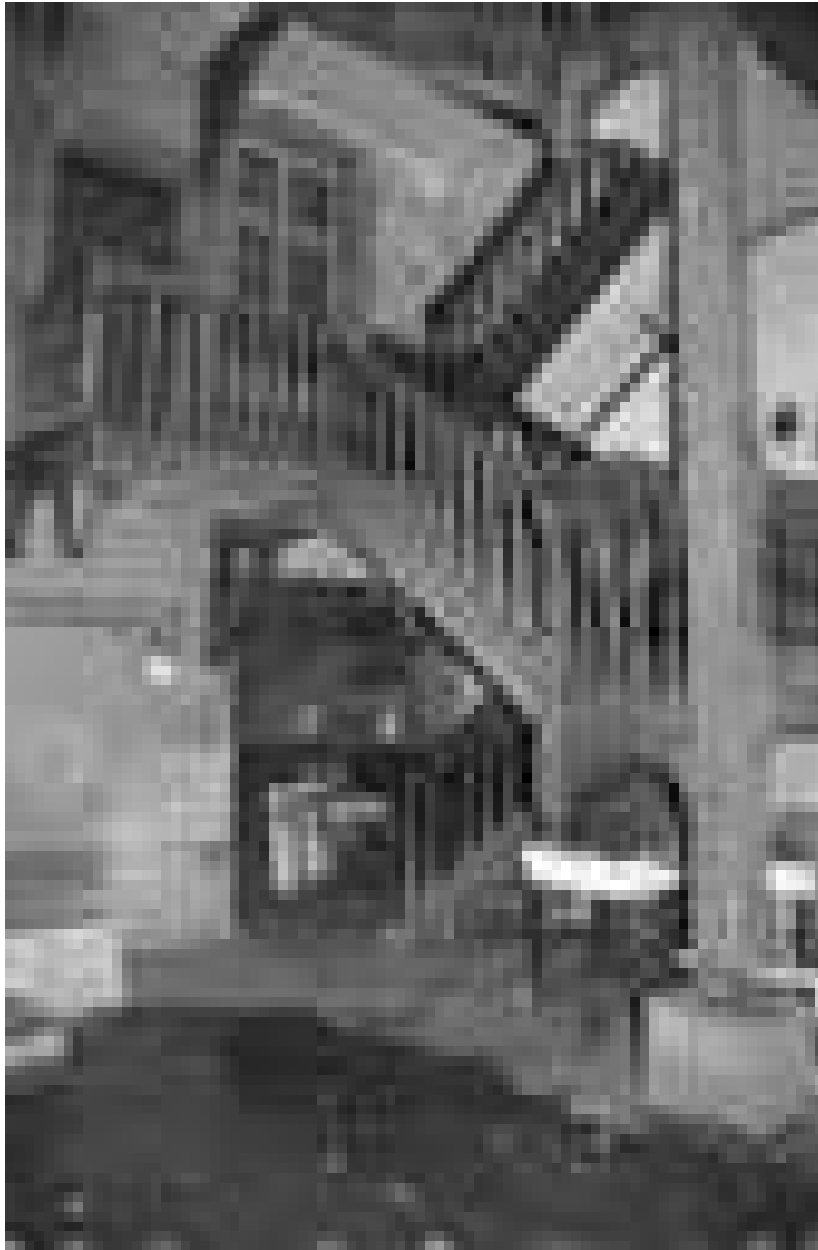
Immeuble : détail de l'escalier sur cour et de la porte d'accès à la cour.
