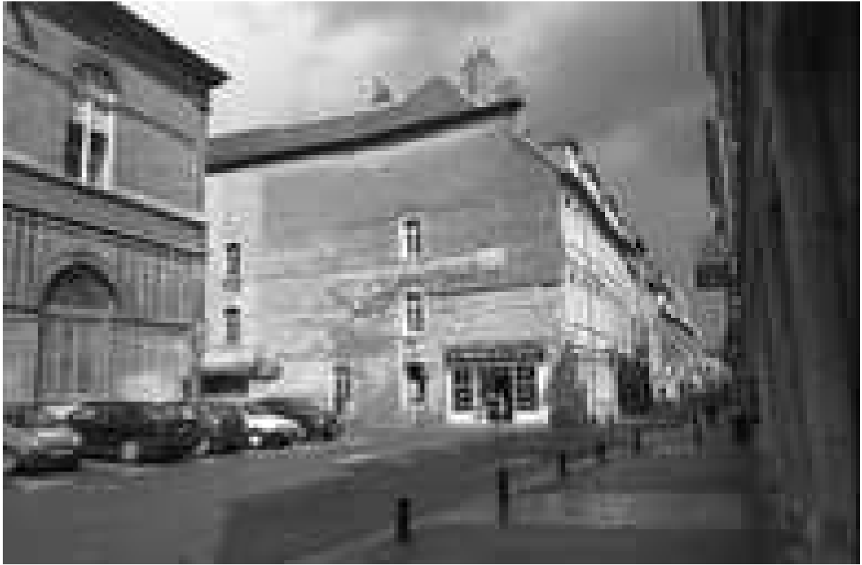
Hôtel et immeuble : vue de la façade latérale gauche, sur la rue Pâris.
