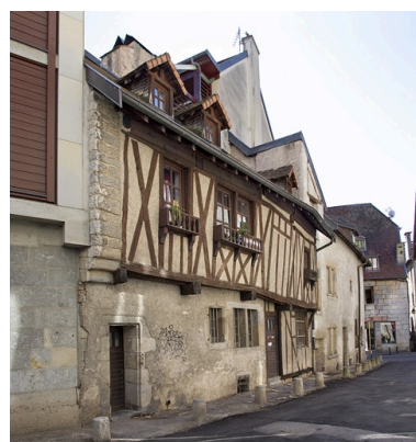
Maison : vue d'ensemble de la façade antérieure à pans de bois, de trois quarts gauche. Phot. Yves Sancey IVR43_20122501696NUC2A
