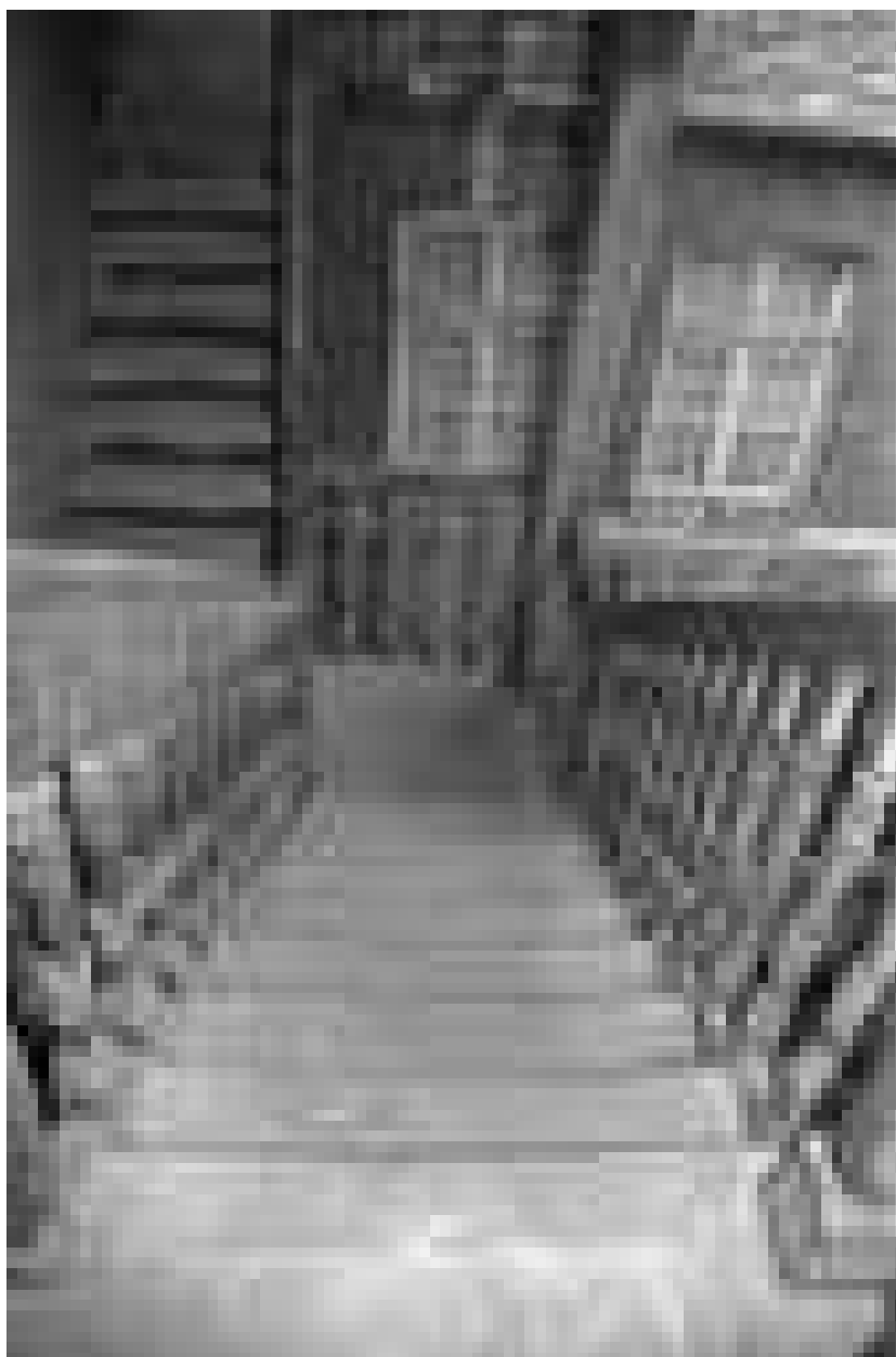
Immeuble : détail d'une volée de l'escalier sur cour.
