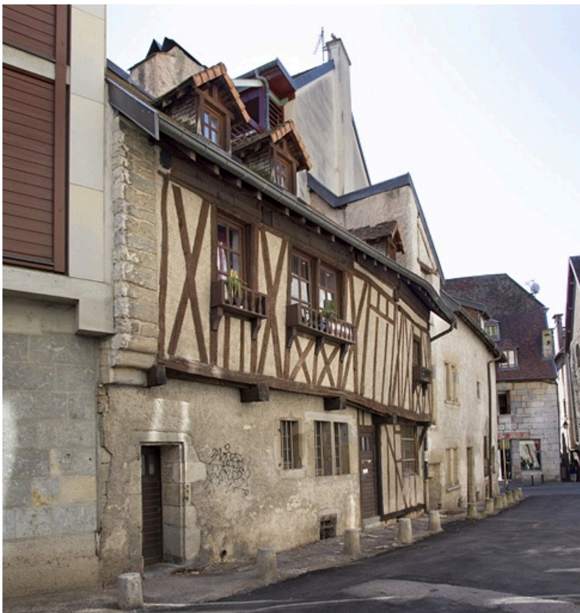
Maison : vue d'ensemble de la façade antérieure à pans de bois, de trois quarts gauche.
