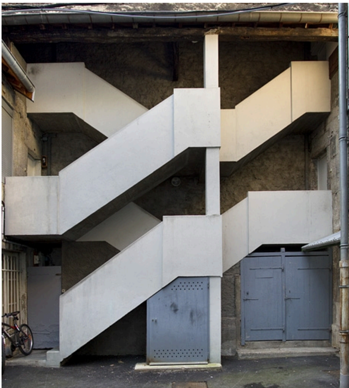
Maison : vue d'ensemble d'un escalier à cage ouverte restauré à la fin du XXe siècle.
