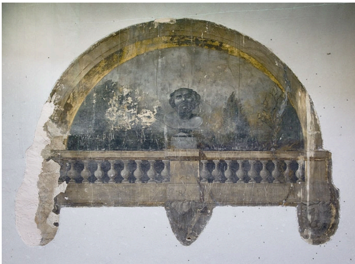
Maison de l'architecte Marnotte : peinture murale située sur le mur à droite de la cour : vue d'ensemble.
