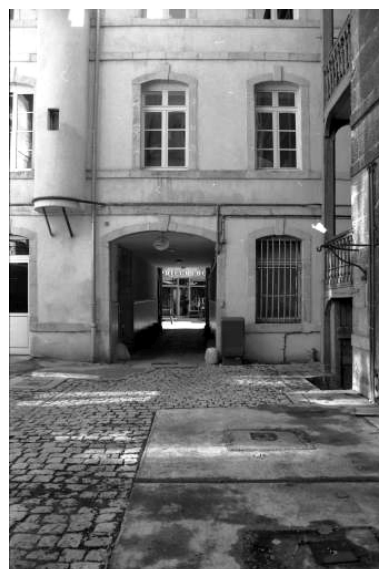
Hôtel et immeuble : façade postérieure du logis principal sur cour : détail partie droite. Phot. Yves Sancey IVR43_19982500006Z
