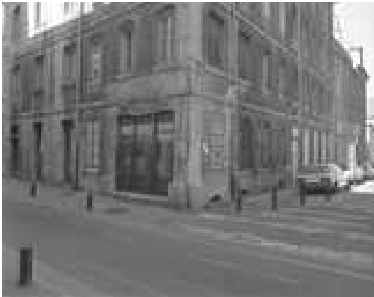
Immeuble : vue d'ensemble depuis l'angle des rues Jean Petit et Courbet.
