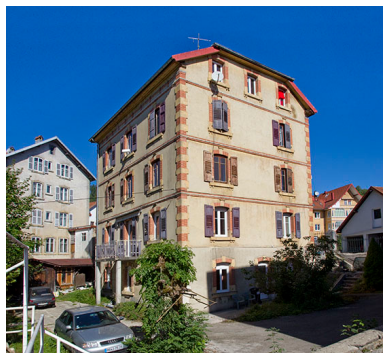
Façades postérieure et latérale gauche.
