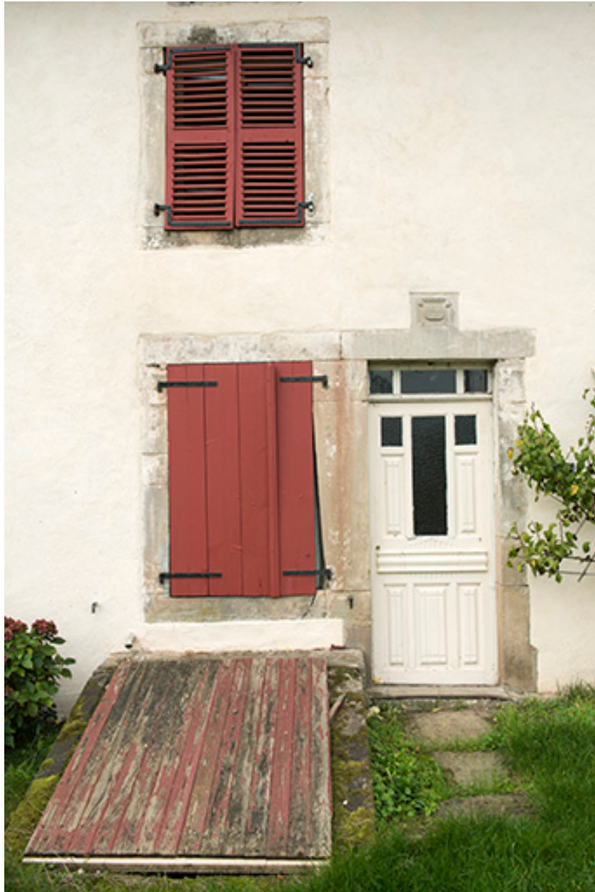
Maison disposant d'un sous-sol.
