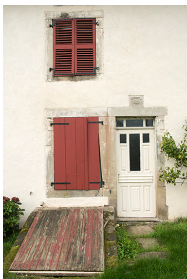
Maison disposant d'un sous-sol. Phot. Sonia Dourlot IVR43_20157001078NUC4A
