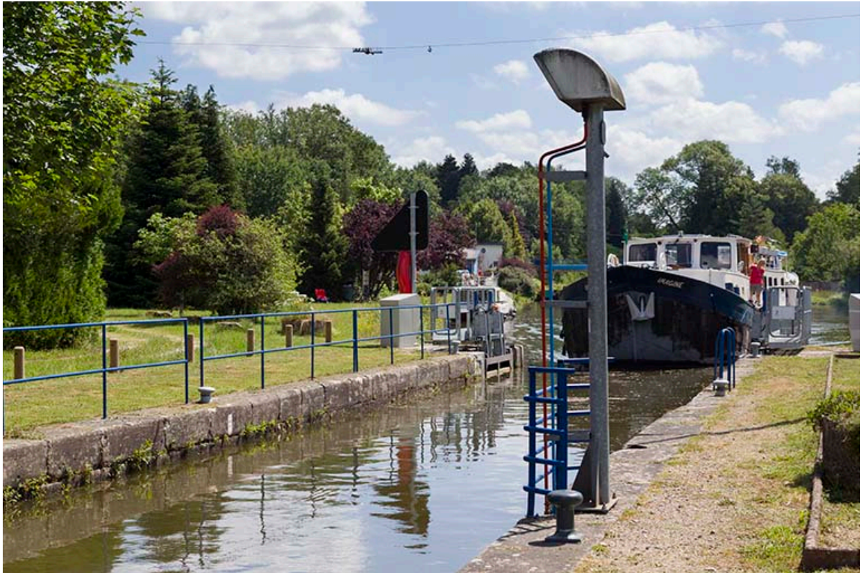
L'écluse de Pont-du-Bois.
