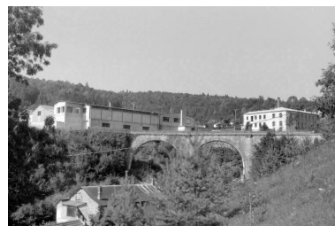
Vue d'ensemble depuis le sud. Phot. Laurent Poupard IVR43_19913901285Z
