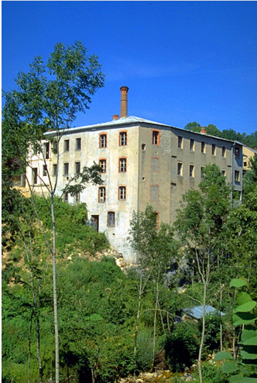
Partie ancienne (atelier de fabrication et bureau).
