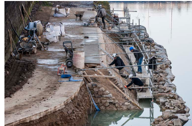
Réfection du perré du chemin de halage en aval du moulin Saint- Paul : ouvriers refaisant le parement. Phot. Jérôme Mongreville IVR43_20152502358NUC4A
