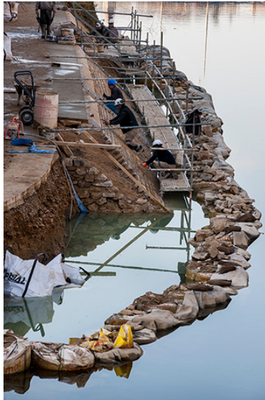
Réfection du perré du chemin de halage en aval du moulin Saint-Paul : coupe du perré. Phot. Jérôme Mongreville IVR43_20152502357NUC4A
