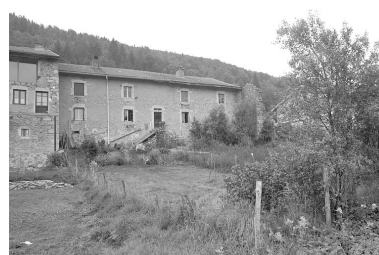
Façade postérieure, vue générale. Phot. Jérôme Mongreville IVR43_19963901611X
