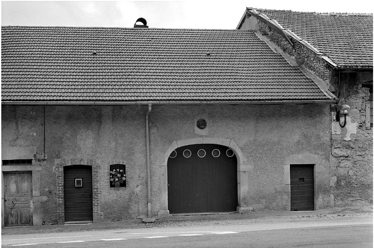
Façade sur la rue.
