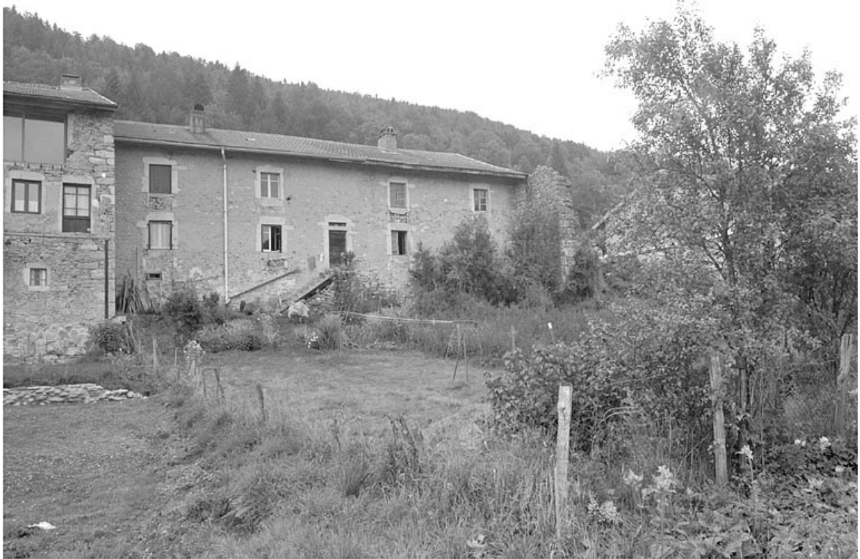
Façade postérieure, vue générale.
