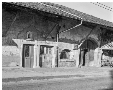
Détail de la façade sur rue. Phot. Bernard Lardière IVR43_19782500352X
