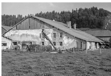
Façade postérieure. Phot. Gilbert Poinot IVR43_19752501468Z
