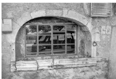
Fenêtre de l'écurie avec mangeoire. Phot. Gilbert Poinot IVR43_19752501466Z
