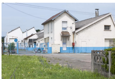
Bâtiments sud et conciergerie depuis le sud-est.
