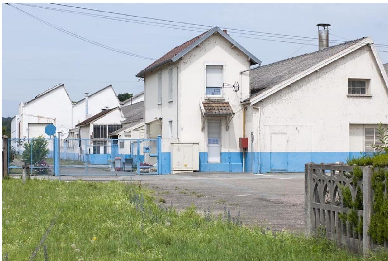
Bâtiments sud et conciergerie depuis le sud-est.
