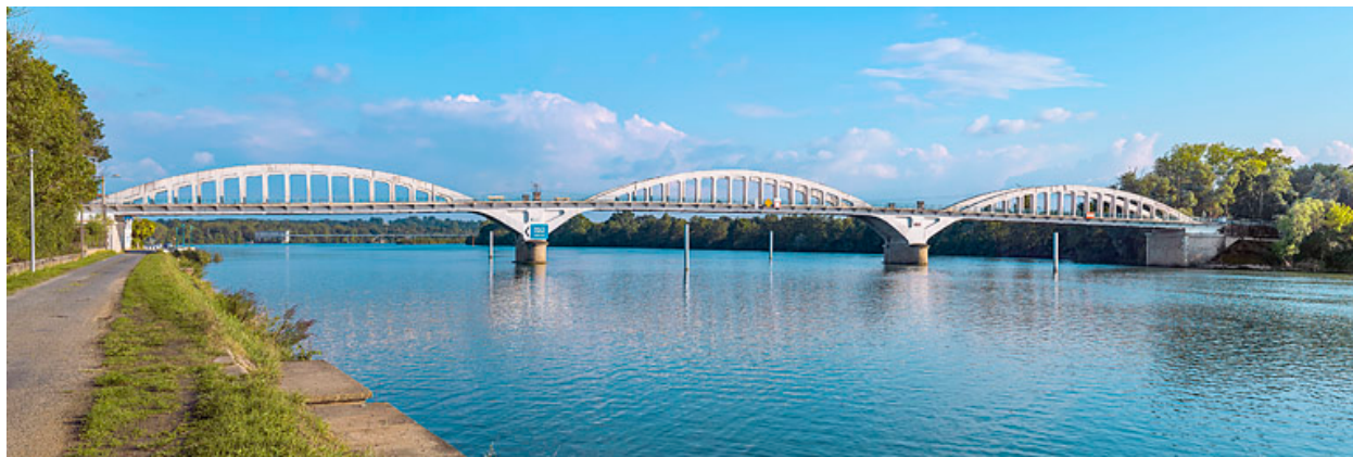
Le pont de Thoissey, vu d'amont depuis la rive gauche. En arrière-plan, le barrage de Dracé.
