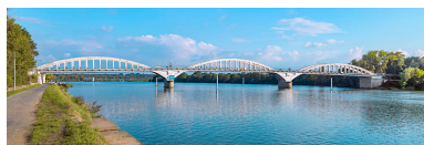
Le pont de Thoissey, vu d'amont depuis la rive gauche. En arrière-plan, le barrage de Dracé.
