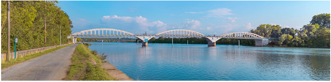
Le pont de Thoissey, vu d'amont depuis la rive gauche. En arrière-plan, le barrage de Dracé.
