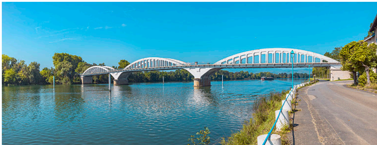
Le pont de Thoissey, vu d'aval, depuis la rive gauche.
