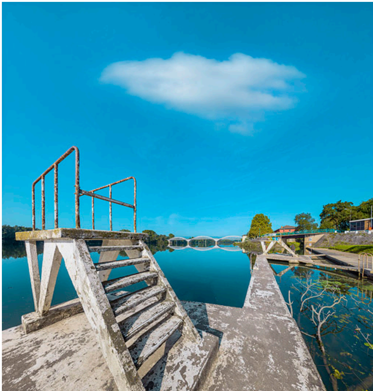
Le pont de Thoissey et le pont sur la Chalaronne, vus d'aval, depuis la rive gauche.
