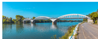
Le pont de Thoissey, vu d'aval, depuis la rive gauche.
