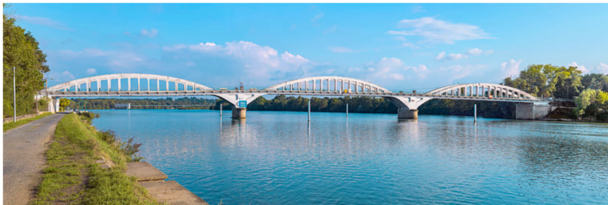
Le pont de Thoissey, vu d'amont depuis la rive gauche. En arrière-plan, le barrage de Dracé.
