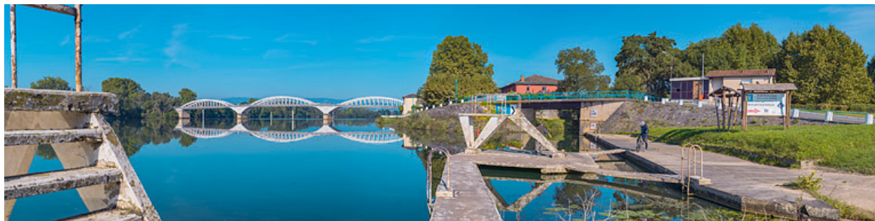
Le pont de Thoissey et le pont sur la Chalaronne, vus d'aval, depuis la rive gauche.
