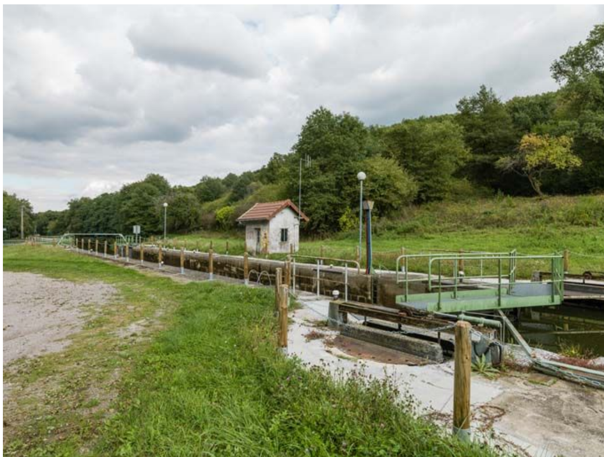
Vue d'ensemble du site d'écluse.
