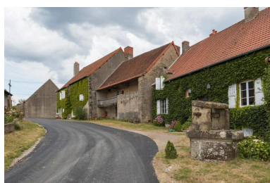
Vue de l'alignement des maisons du hameau des Bouffiers Phot. Pierre-Marie Barbe-Richaud IVR26_20187100157NUC4A
