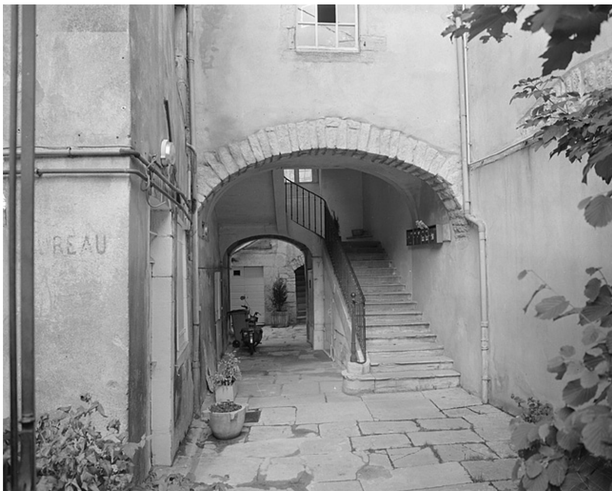
Escalier formant passage d'accès à la cour.
