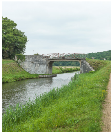
Vue du pont.
