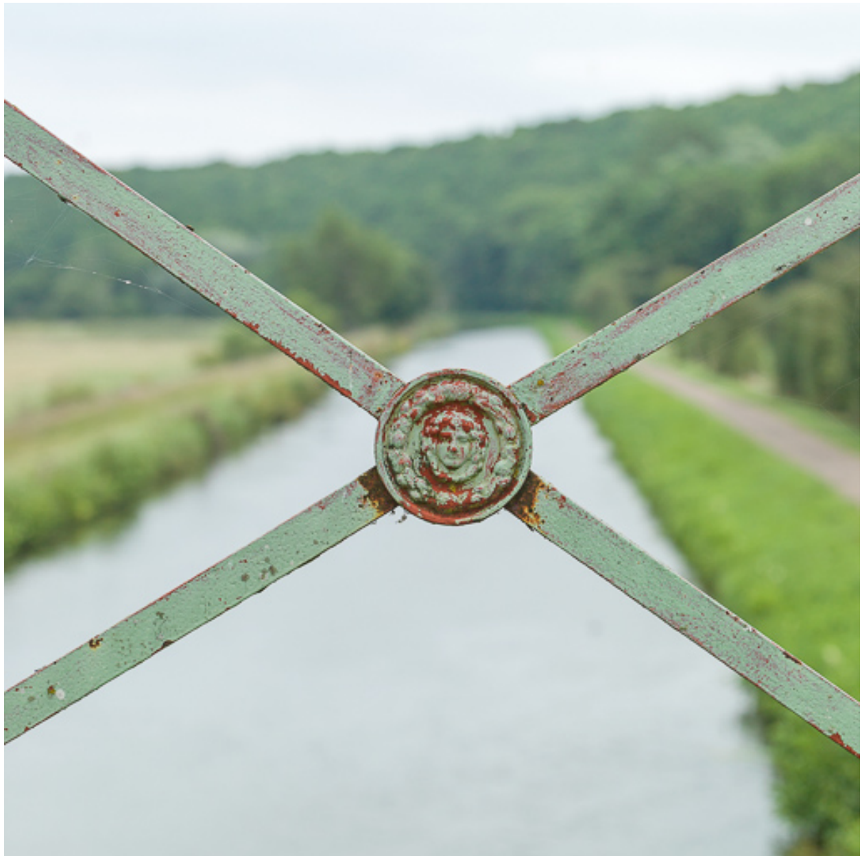
Détail du garde-corps.
