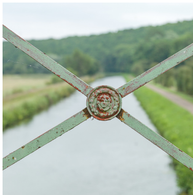
Détail du garde-corps.
