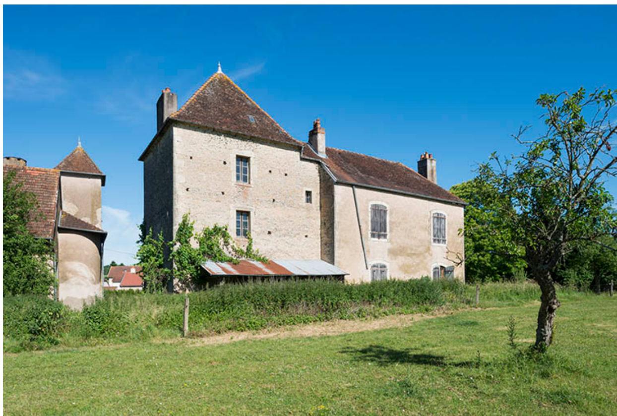
La façade postérieure du bâtiment XVIIIe.
