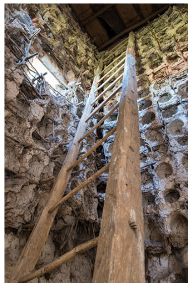
Les boulins du colombier. Phot. Jérôme Mongreville IVR43_20177001090NUC4A
