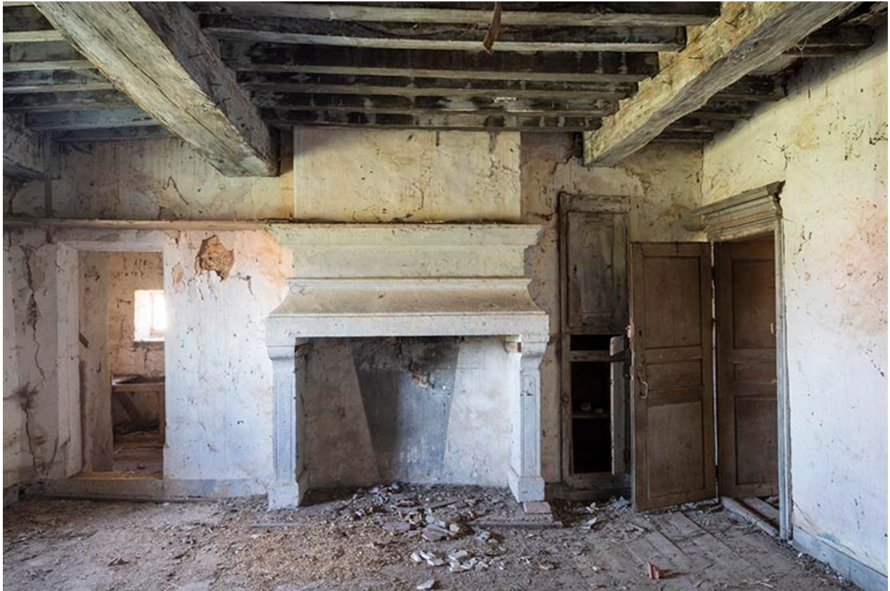
Cheminée de la chambre, logis 16e siècle.
