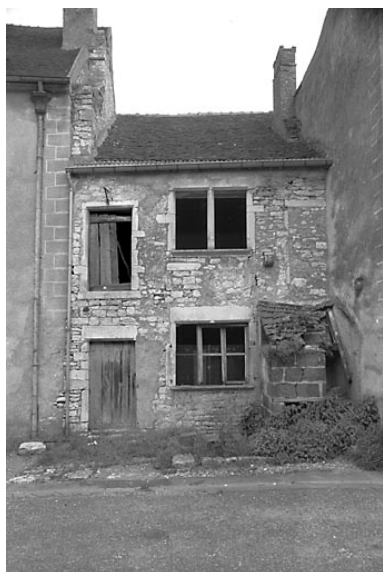
Maison située rue Gollu : façade antérieure. Phot. Bernard Lardière IVR43_19817000792Z
