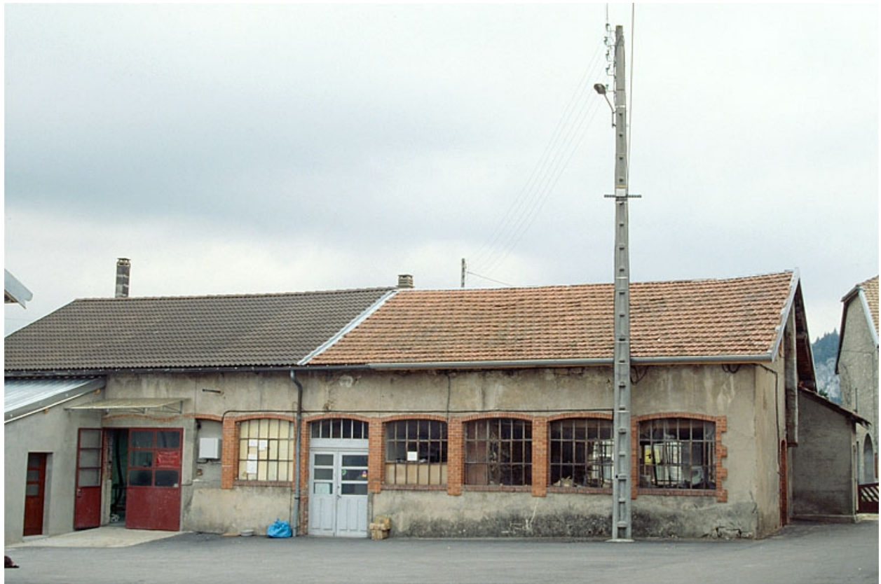
Façade antérieure du second bâtiment.
