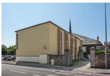
Façades postérieure et latérale droite. Phot. Pierre-Marie Barbe-Richaud IVR26_20212100065NUC4A
