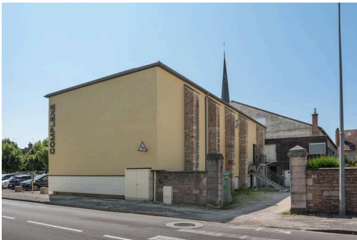
Façades postérieure et latérale droite.
