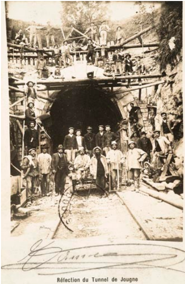
Réfection du tunnel de Jougne, 1909. Phot. IVR43_20102501523NUC4A
