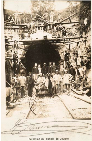
Réfection du tunnel de Jougne, 1909. Phot. IVR43_20102501523NUC4A
