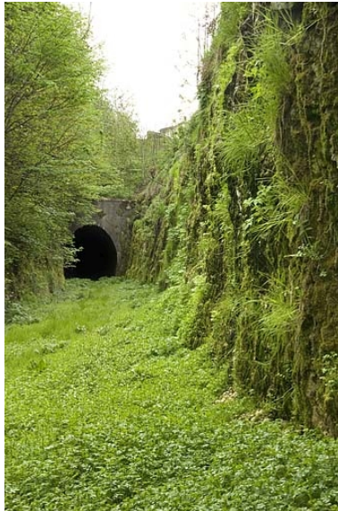
Tunnel et tranchée. Phot. Jérôme Mongreville IVR43_20092500491NUC2A
