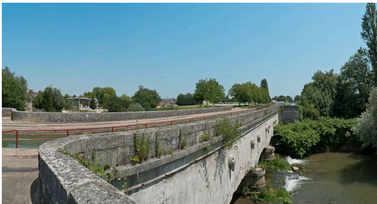
Vue du pont-canal.
