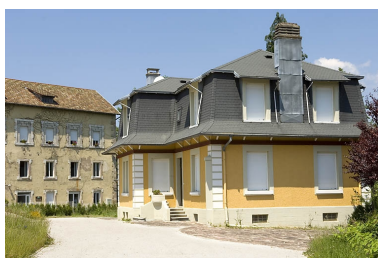
Ancien atelier de fabrication et logement patronal. Phot. Jérôme Mongreville IVR43_20077000679NUCA
