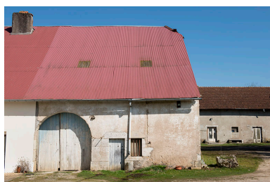
Site de l'ancien moulin Neuf. Phot. Jérôme Mongreville IVR43_20177000234NUC4A
