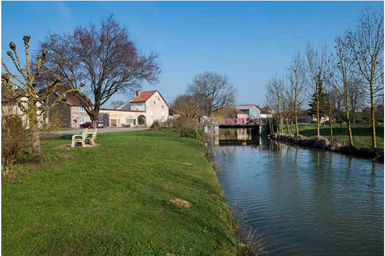
Le ruisseau avec le pont en arrière plan.
