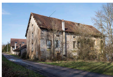
Vue générale du site du Moulin-Atre. Phot. Jérôme Mongreville IVR43_20177000124NUC4A
