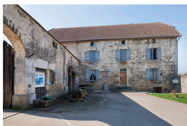
Cour de la maison. Phot. Jérôme Mongreville IVR43_20177000229NUC4A
