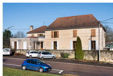
L'ancien orphelinat. Phot. Jérôme Mongreville IVR43_20177000097NUC4A
