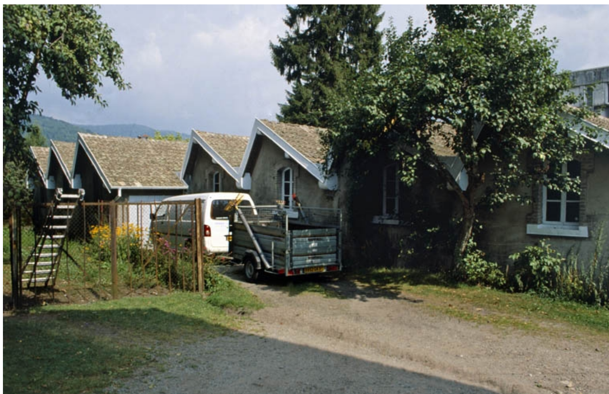
Vue d'ensemble de l'atelier de fabrication.
