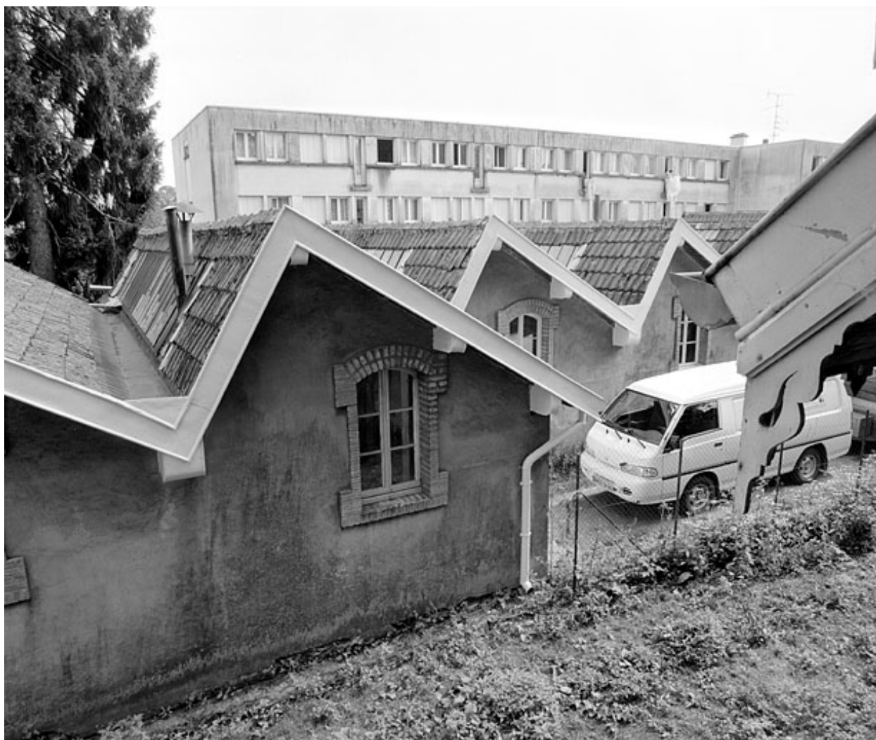
Sheds de l'atelier de fabrication.
