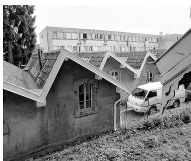
Sheds de l'atelier de fabrication. Phot. Yves Sancey IVR43_19999000322X
