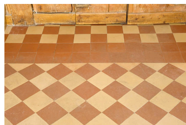
Cuisine du rez-de- chaussée : carreaux au sol. Phot. Jérôme Mongreville IVR43_20092500091NUC2A
