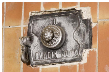
Plaque d'obturation marquée Baudin Jura. Phot. Jérôme Mongreville IVR43_20092500088NUC2A
