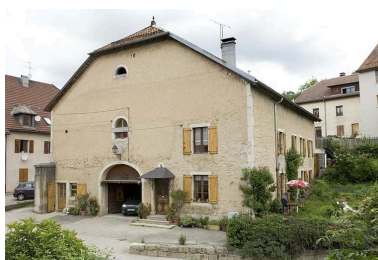
Façade antérieure, route des Alpes. Phot. Jérôme Mongreville IVR43_20092500789NUC2A
