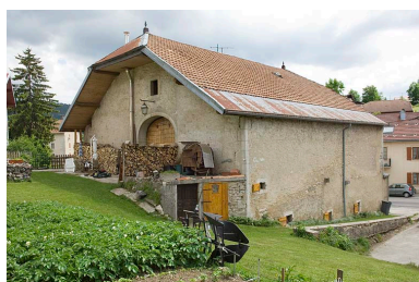
Façade postérieure et façade latérale gauche. Phot. Jérôme Mongreville IVR43_20092500790NUC2A
