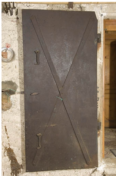
Porte coupe-feu ouverte. Phot. Jérôme Mongreville IVR43_20092500094NUC2A
