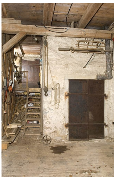
Porte coupe-feu à deux vantaux, vue du côté parties agricoles. Phot. Jérôme Mongreville IVR43_20092500096NUC2A
