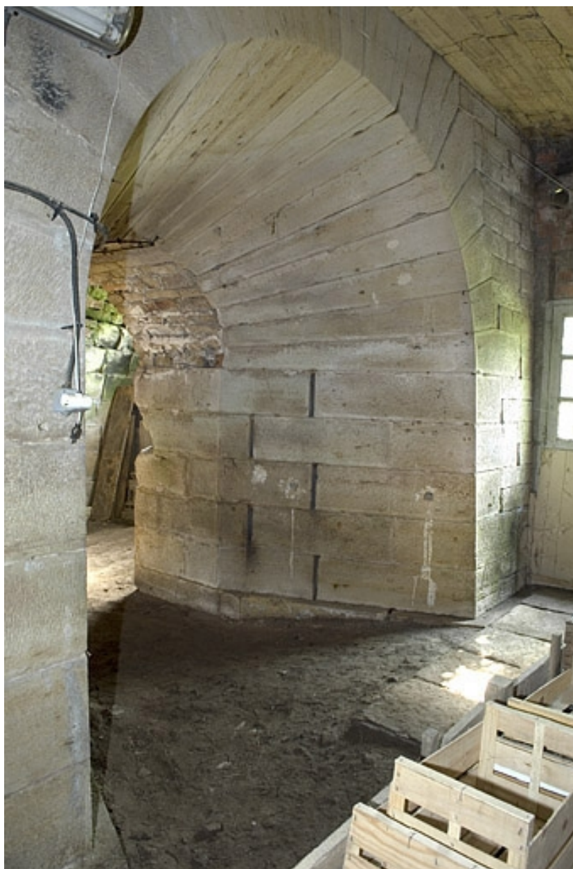
Détail d'une embrasure et de son appareillage.
