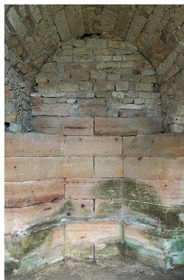
Creuset (?) du haut fourneau. Phot. Jérôme Mongreville IVR43_20067000278NUCA
