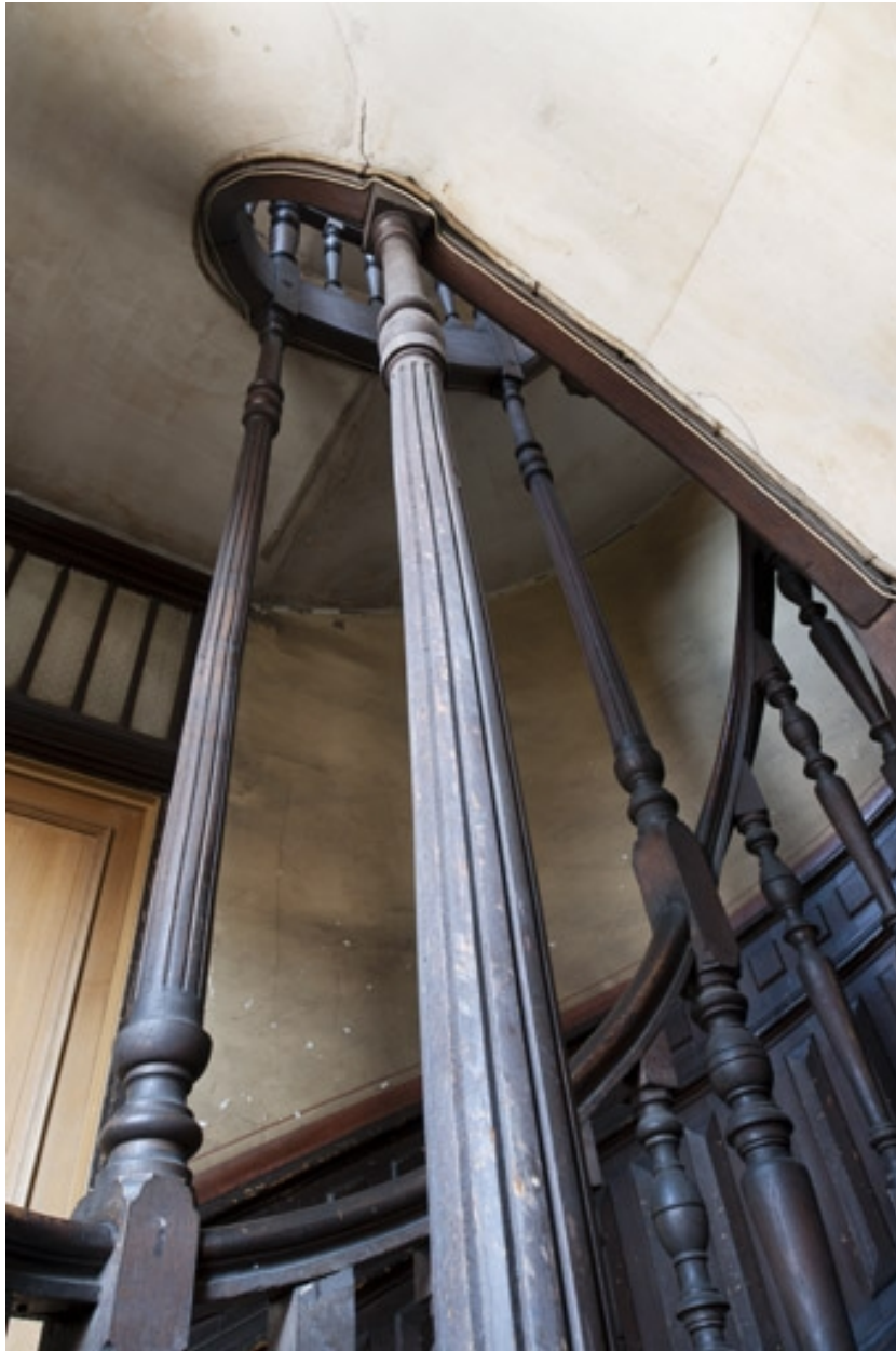
Détail des montants de l'escalier.
